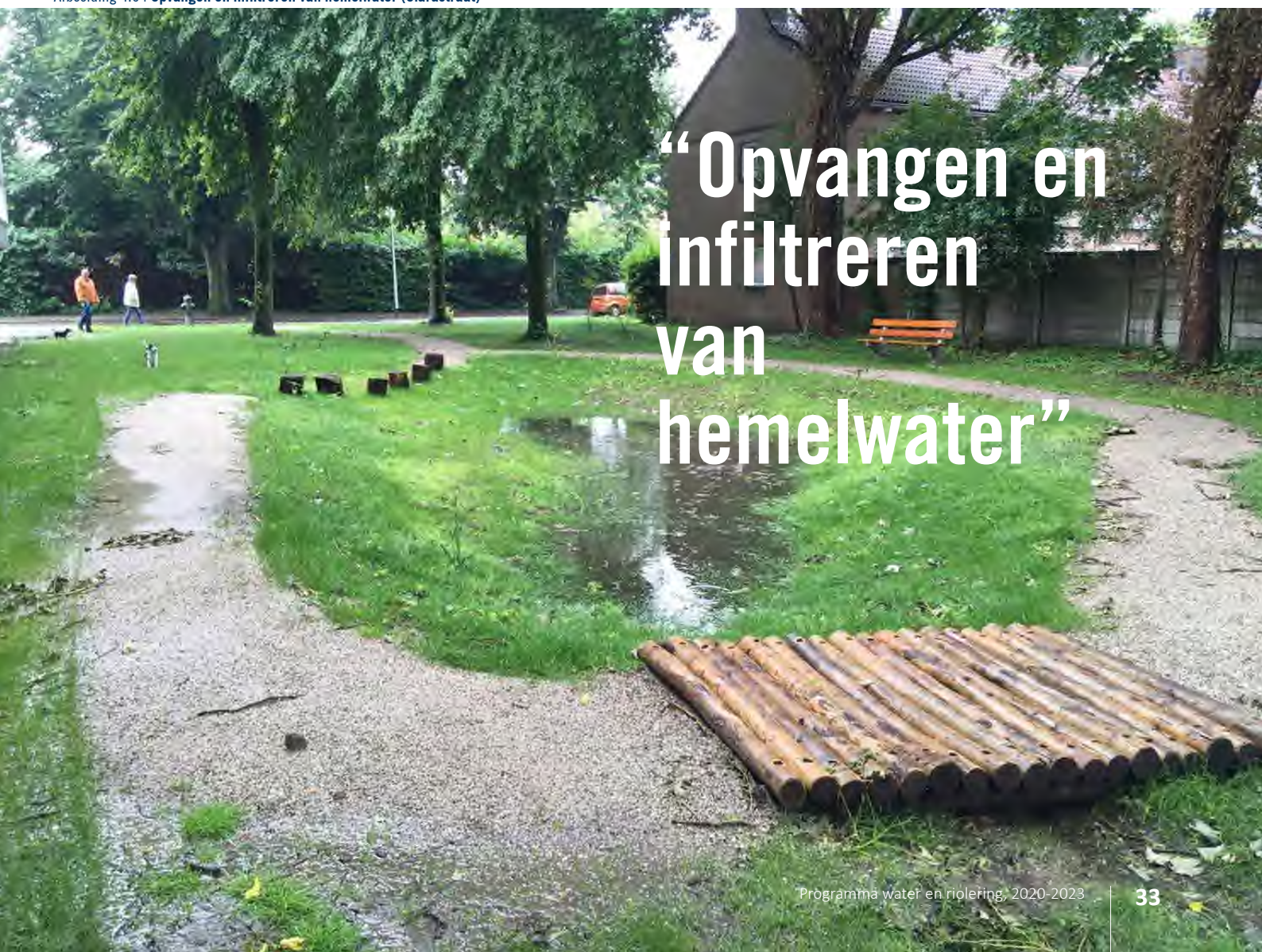
Afbeelding 4.6 | Opvangen en infiltreren van hemelwater (Clarastraat)
