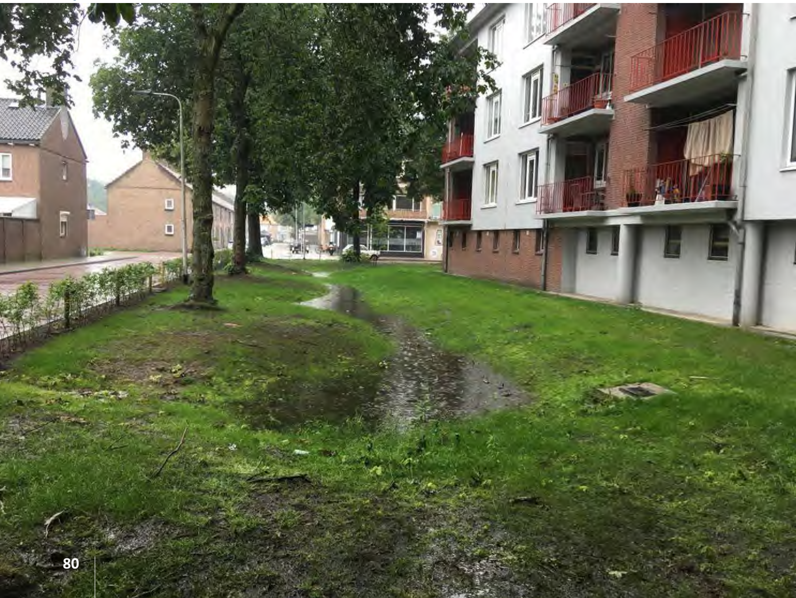
Afbeelding E.2 | Vasthouden van hemelwater in een wadi (Basiliusstraat)
