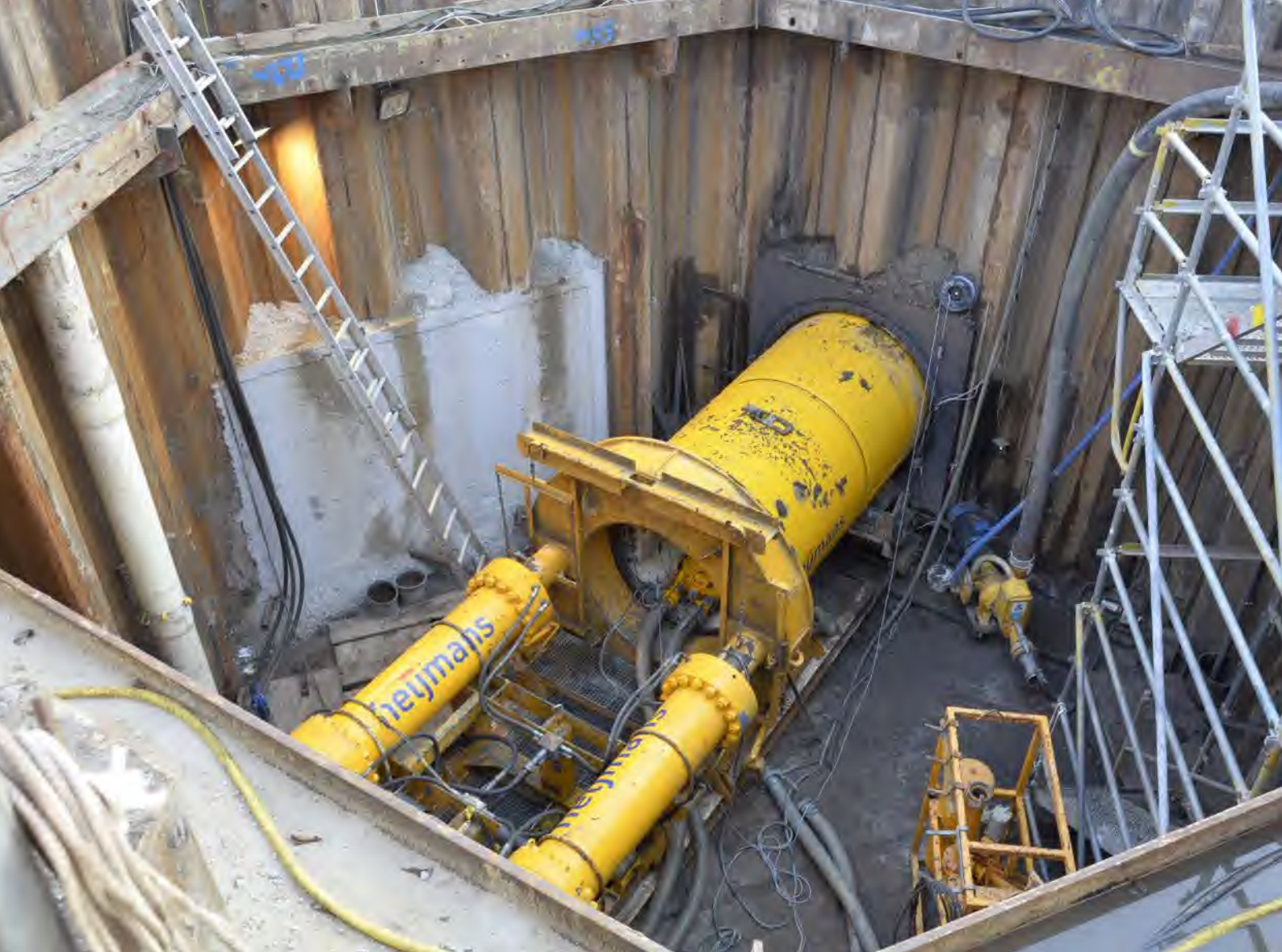
Afbeelding E.7 | Een ondergrondse boring biedt uitkomst bij drukte in de bovengrond
