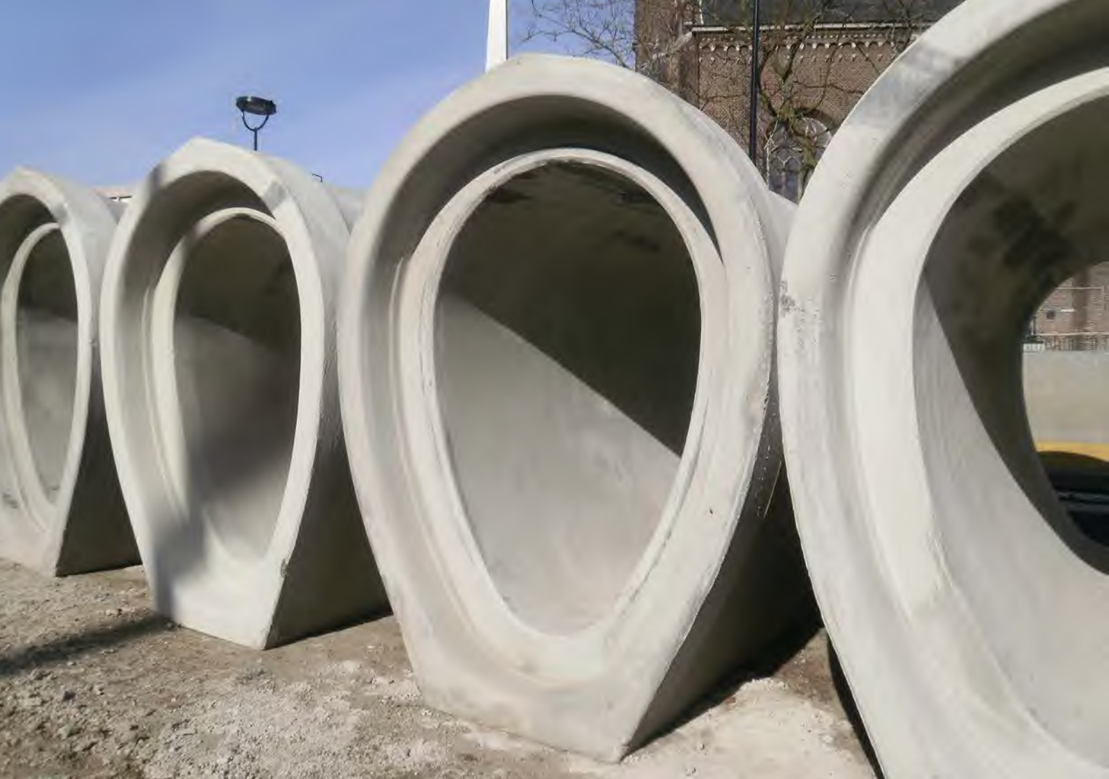
Afbeelding E.1 | Lagere vuilemissie door minder slibbezinking als gevolg van ei-vormige riolen
