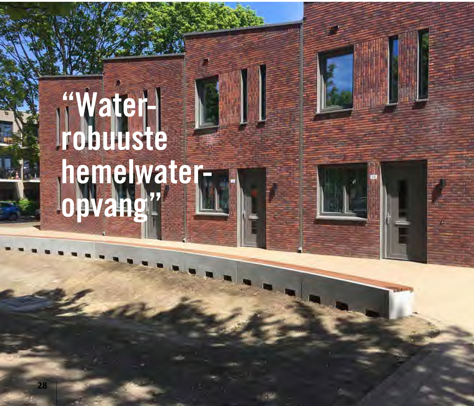
Afbeelding 4.2 | Waterrobuuste hemelwateropvang Hendrik van Tulderstraat
