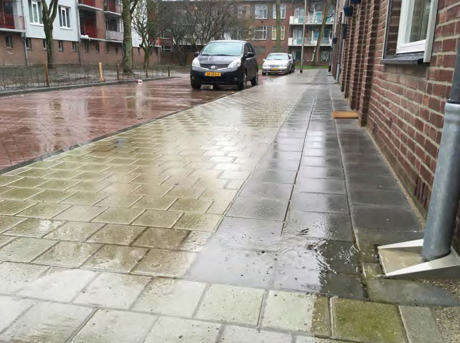
Afbeelding E.3 | Bovengrondse afvoer van hemelwater zal steeds vaker gaan voorkomen (Basiliusstraat)
