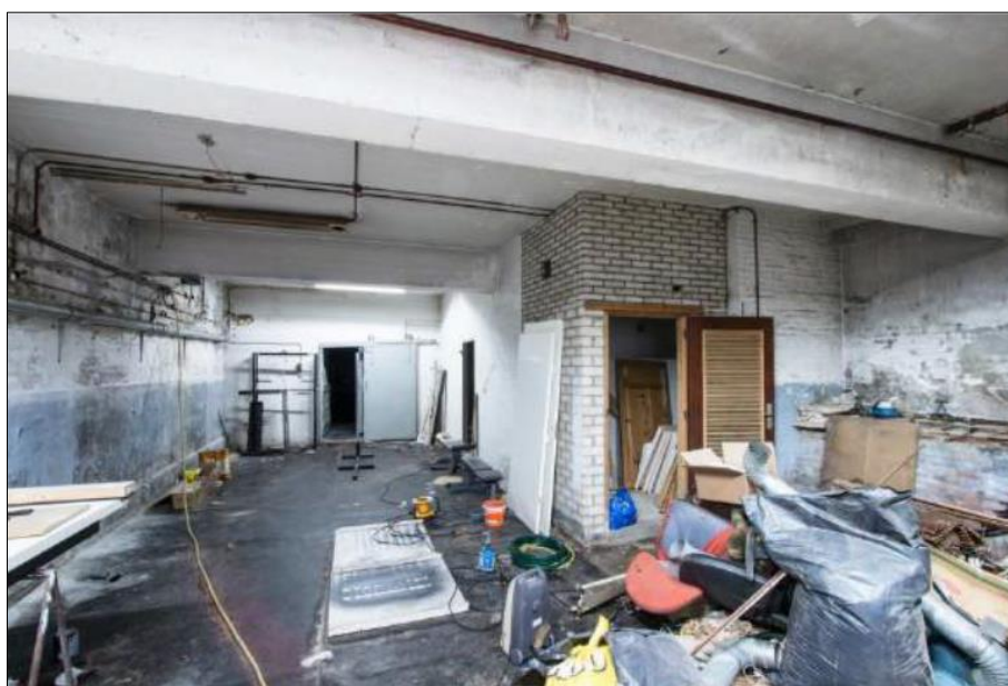
Figuur 15. Foto van de kelder onder het Duivenhuis uit 1928 (noordwesten van het plangebied; bron: Oldemenger, 2019).
