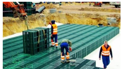
Figuur 6 Voorbeelden van waterberging onder aaneengesloten verharde oppervlakken
