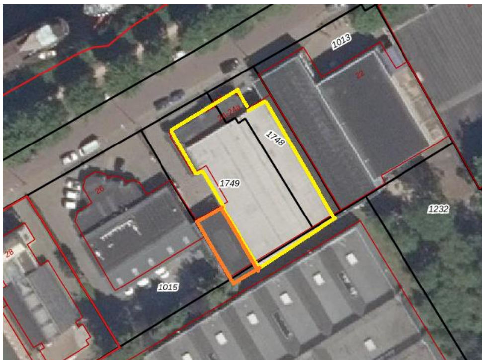
Figuur 12: Havendijk 24/24b op een luchtfoto uit 2019 (bron: Kadaster).
