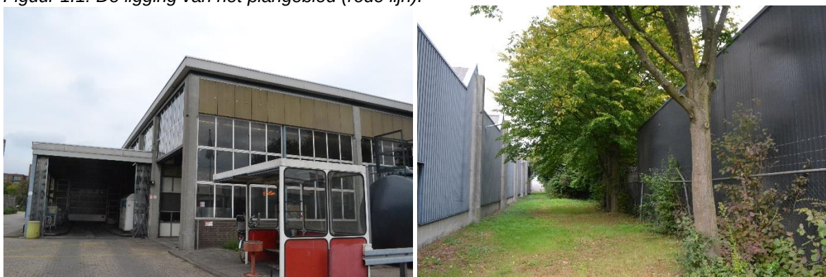
Figuur 1.2 Situatie van het gebouw van Arriva dat wordt gesloopt. Rechts is de situatie aan de achterzijde van dit gebouw.
