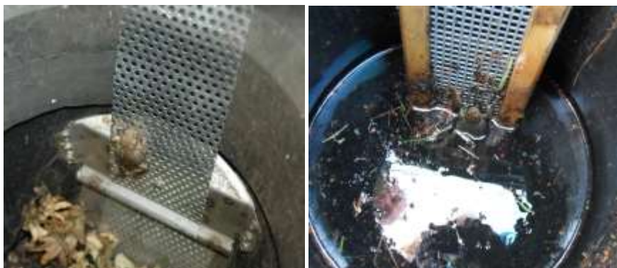
Figuur 16: Amfibieëntrap in een straatkolk.
