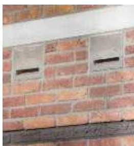
Figuur 11: Inbouwkast geïntegreerd in de gevel.
