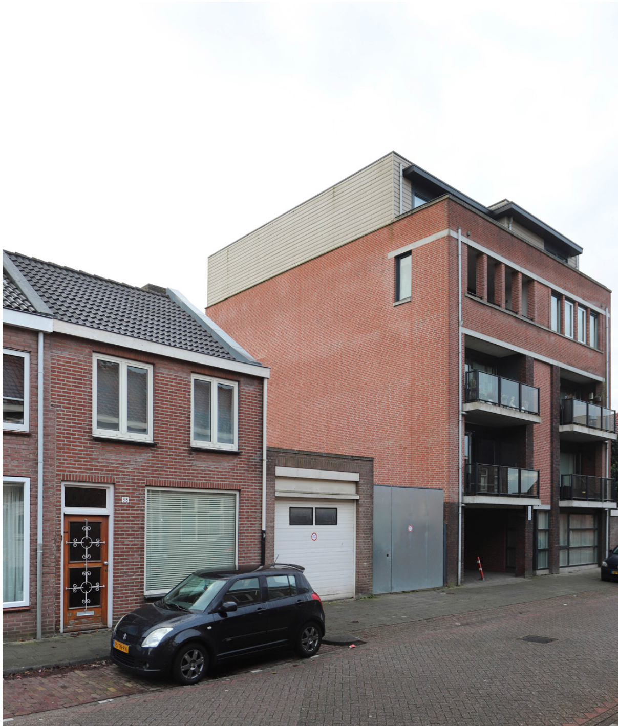
Afb. 1a: Bestaande situatie
