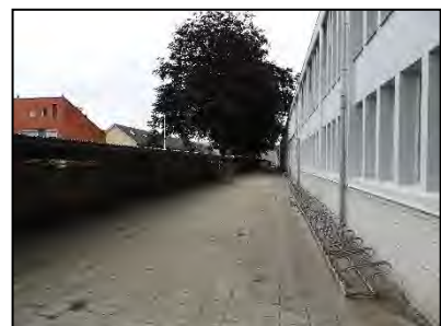
Figuur 8. Gebouw aan de oostzijde van de onderzoekslocatie.
