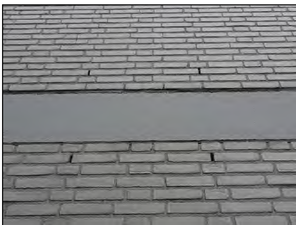
Figuur 13. Geschikte open stootvoegen in de buitengevel van het gebouw.
