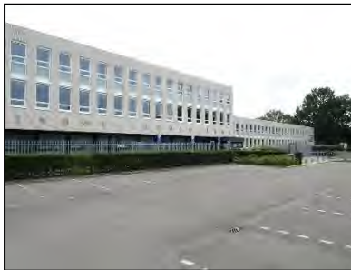
Figuur 3. Hoofdgebouw met parkeerplaatsen aan de westzijde van de onderzoekslocatie.
