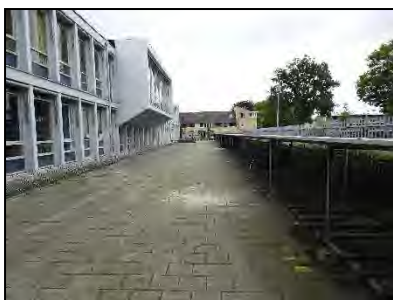
Figuur 9. Gebouw aan de zuidzijde van de onderzoekslocatie.
