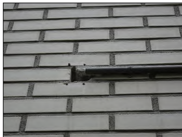
Figuur 14. Geschikte opening in de buitengevel van het gebouw.
