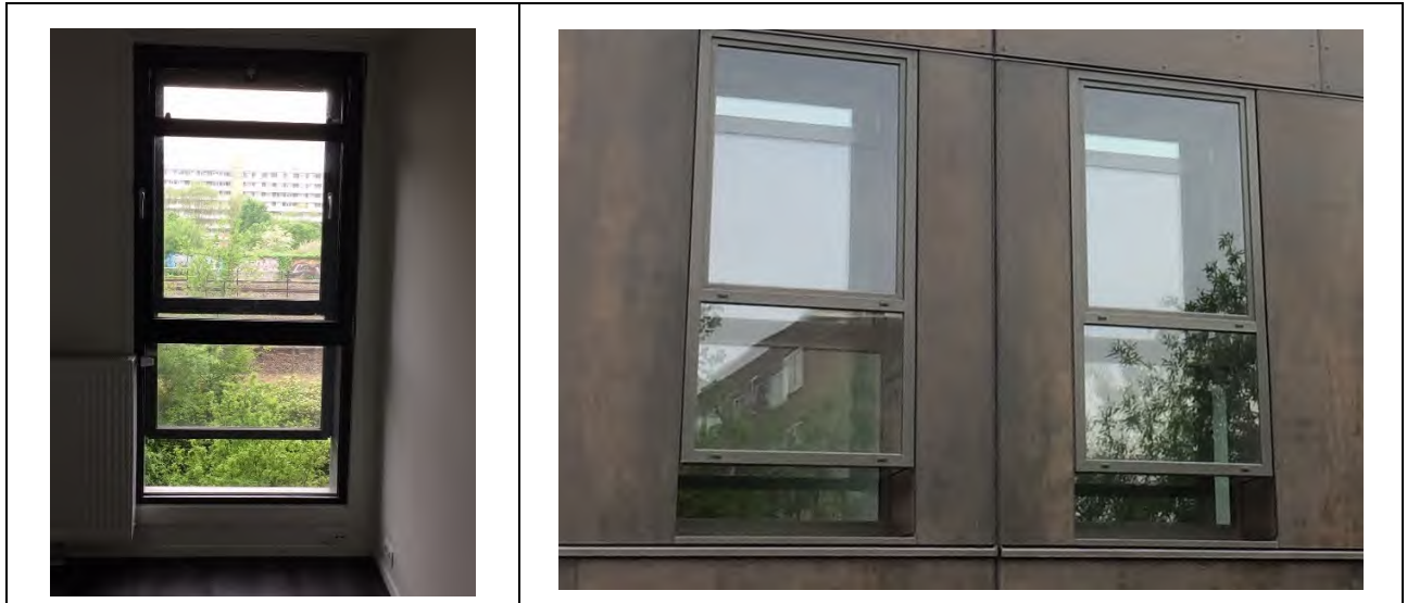
Figuur 7.3: Harbour Fenster – binnenaanzicht en buitenaanzicht (project: Westkavel/Laan Van Spartaan in Amsterdam)
