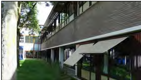
Zuidelijke vleugel hoofdgebouw
