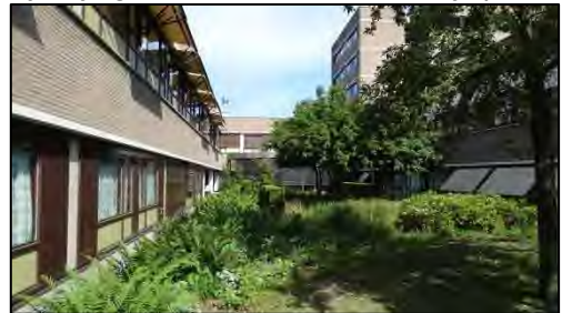
Zuidoostelijke vleugel hoofdgebouw
