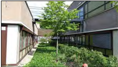
Zuidoostelijke vleugel hoofdgebouw
