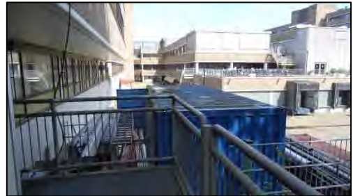
Afleverpunt oostkant hoofdgebouw
