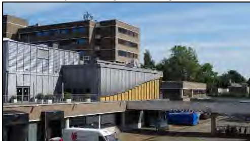
Overzicht afleverpunt en hoofdgebouw
