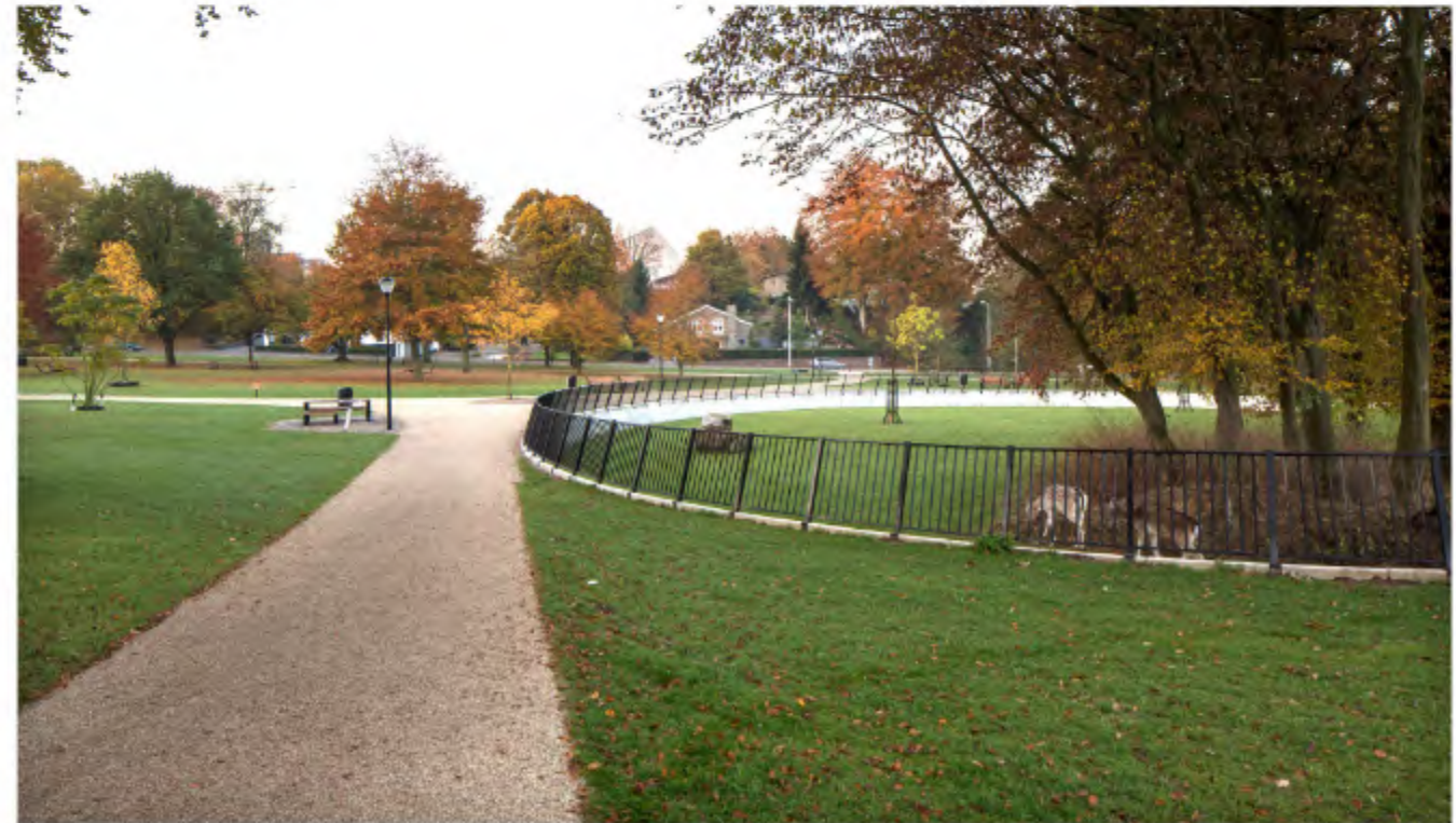
of asfalt met afstrooilaag (stadspark Kerkrade)
