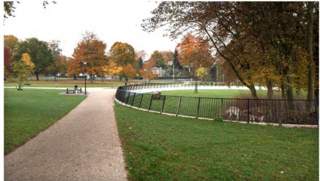
of asfalt met afstrooilaag (stadspark Kerkrade)
