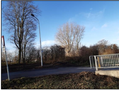
Lantaarnpaal bij de bocht in de weg aan de zuidkant van de brug. Overige verlichting ontbreekt.
