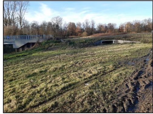
De noordelijke oever, met de faunatunnel onder de Leijweg rechts op de afbeelding.
