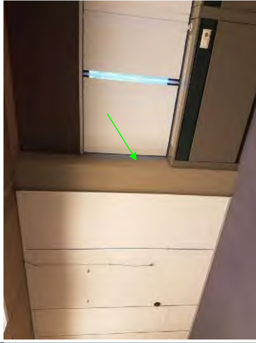
Foto 73: Laagbouw, asbestvrije bitumen op stroken op beplating convectors (M226-V)
