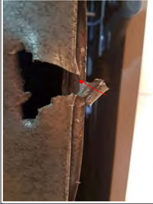
Foto 55: Geb. 1, t/m 4 e verdieping: kit in felsnaad luchtkanaal (M201-AA)
