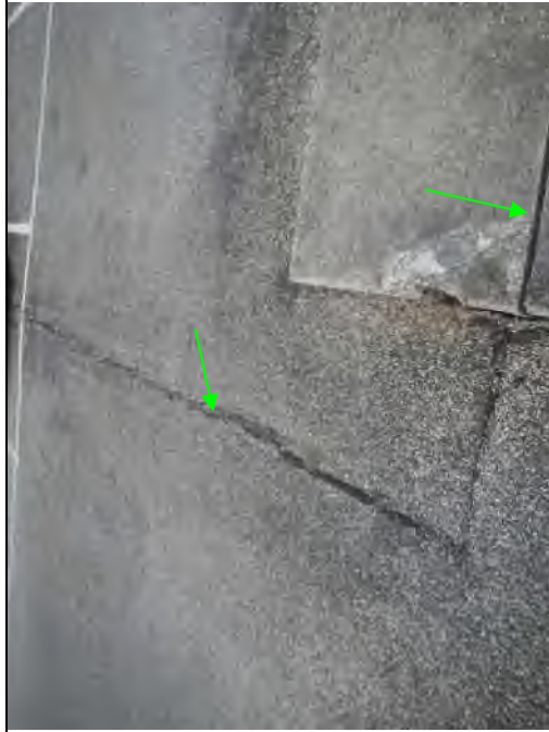
Foto 49: Geb.1, resten kit tussen gevelelementen (M112-O)
