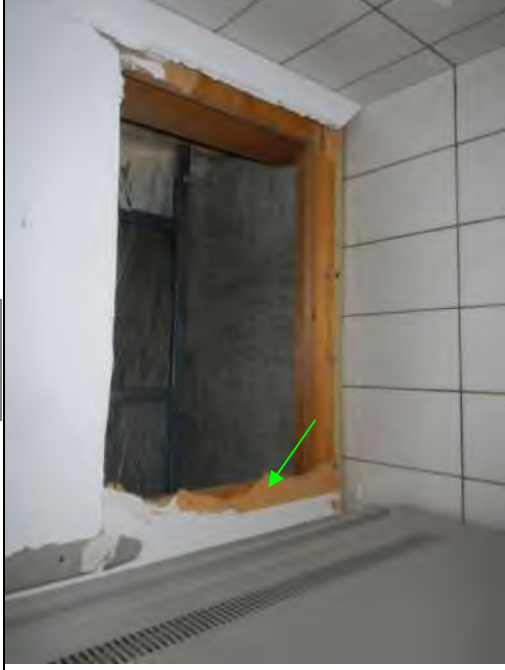
Foto 32: Geb. 1, 2° verd., asbestvrij zachtboard tegen plafond (M015-V)
