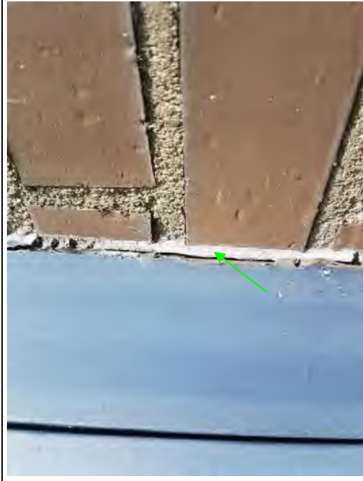
Foto 83: Geb.2, kit langs pui kopgevel (M207-V)
