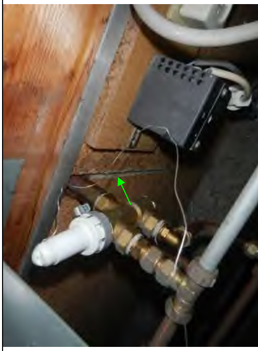
Foto 27: Geb. 1, doorvoer luchtkanaal, asbestvrij kit tussen flenzen (M004-V)
