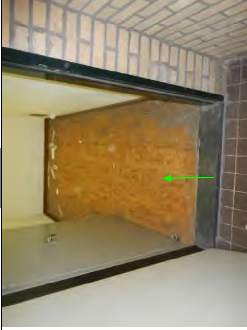
Foto 26: Geb. 1, archief, asbestvrije bitumen onder twee lagen zeil (M003-V)
