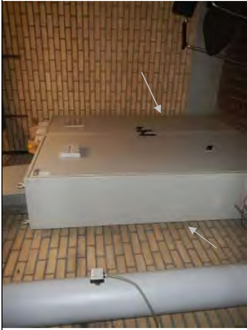
Foto 19: Geb. 1, CV-ruimte losse platen achter kast (M018-ZA, gesaneerd)
