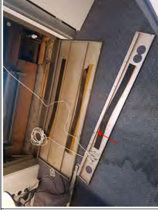
Foto 61: 3c Geb. 1: bitumen op stroken beplating convectors (M225-AA/4° verd.: M224-AA/2° verd.)
