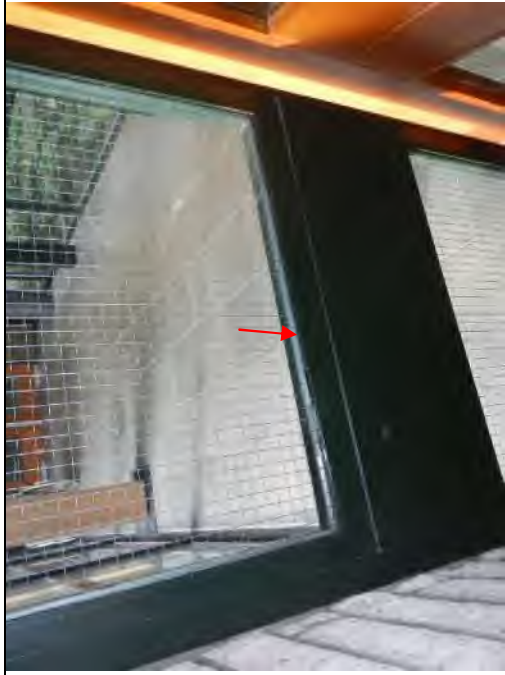
Foto 7: Laagbouw, techn. ruimte, in gang, pakking tussen flenzen (M002-AA)
