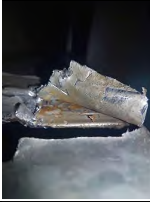
Foto 58: Geb. 1, t/m 4 e verdieping: kit in felsnaad luchtkanaal (M221-ZA)
