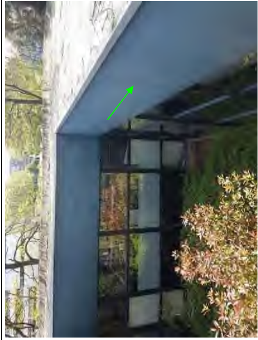
Foto 71: Asbestvrije kit tussen gevelbeplating patio (M206-V)
