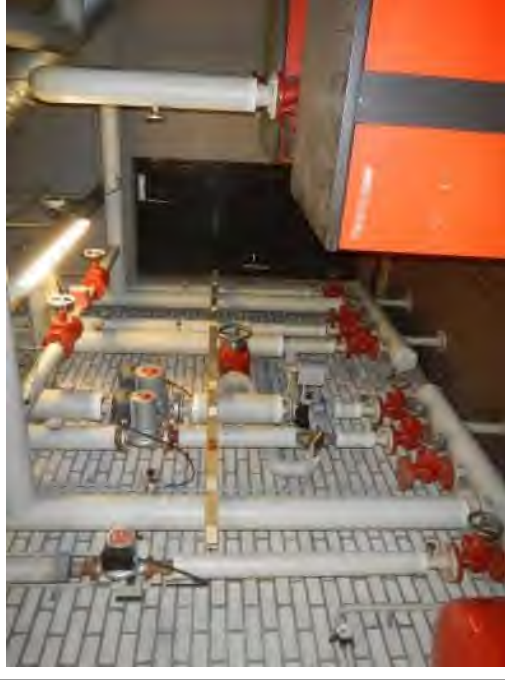
Foto 33: Geb. 2, CV ruimte, asbestvrije pakkingen tussen flenzen (M011-V)
