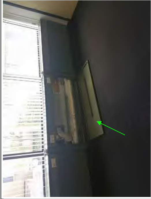
Foto 73: Laagbouw, asbestvrije bitumen op stroken op beplating convectors (M226-V)
