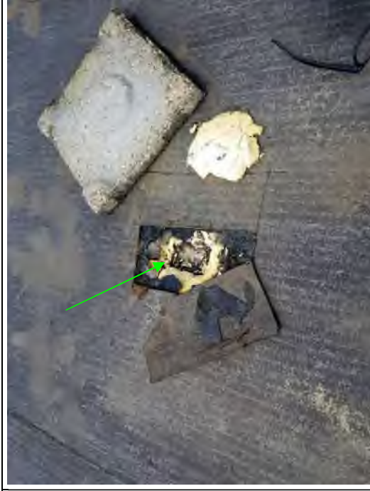
Foto 67: Asbestvrije bitumen dakbedekking diverse daken (M210 t/m M215-V)
