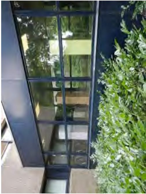
Foto 49: Geb.1, resten kit tussen gevelelementen (M112-O)
