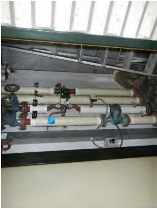
Foto 7: Laagbouw, techn. ruimte, in gang, pakking tussen flenzen (M002-AA)
