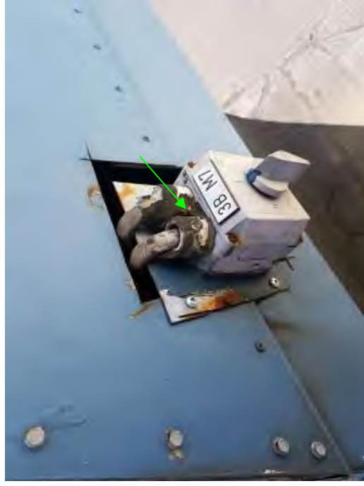
Foto 81: Geb.1, kit op kabelwartels, afzuiging keuken op dak (M209-V)
