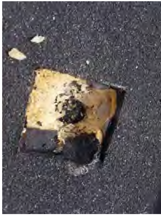
Foto 68: Asbestvrije bitumen dakbedekking diverse daken (M210 t/m M215-V)
