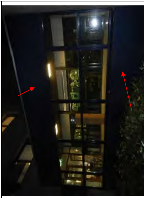
Foto 9: Laagbouw, glaskit kozijnen branddeuren (M008-AA)
