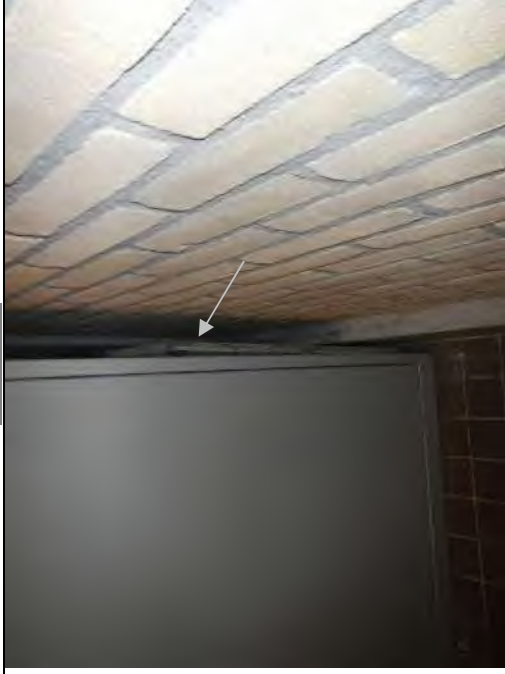
Foto 20: Geb. 1, CV-ruimte losse platen achter kast (M018-ZA, gesaneerd)
