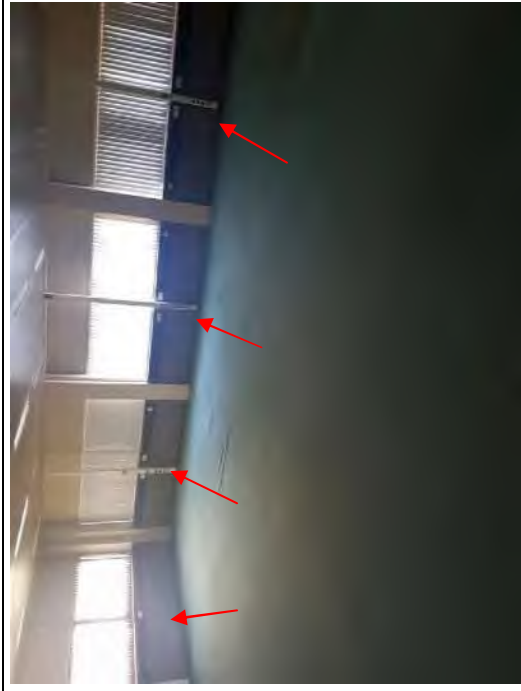
Foto 59: 3a Geb. 1, begane grond: bitumen op stroken beplating convectors (M203-AA)
