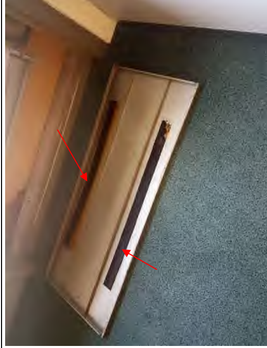
Foto 60: 3b Geb. 1: bitumen op stroken beplating convectors (M225-AA/4° verd.: M224-AA/2° verd.)
