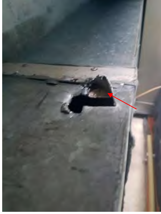
Foto 57: Geb. 1, t/m 4 e verdieping: kit in felsnaad luchtkanaal (M221-ZA)
