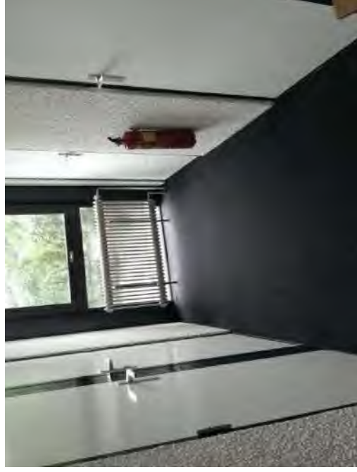
Foto 32: Geb. 1, 2° verd., asbestvrij zachtboard tegen plafond (M015-V)
