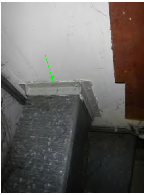
Foto 27: Geb. 1, doorvoer luchtkanaal, asbestvrij kit tussen flenzen (M004-V)
