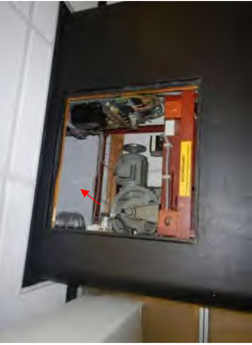
Foto 19: Geb. 1, CV-ruimte losse platen achter kast (M018-ZA, gesaneerd)
