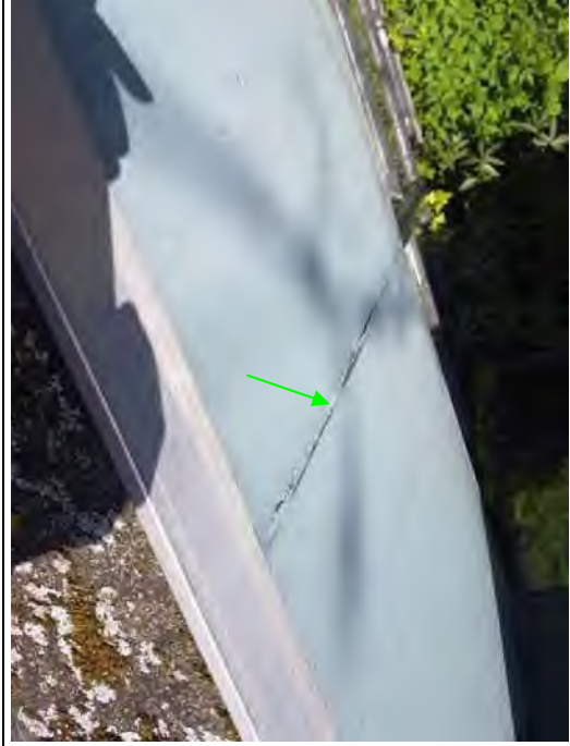
Foto 72: Asbestvrije kit tussen gevelbeplating patio (M206-V)
