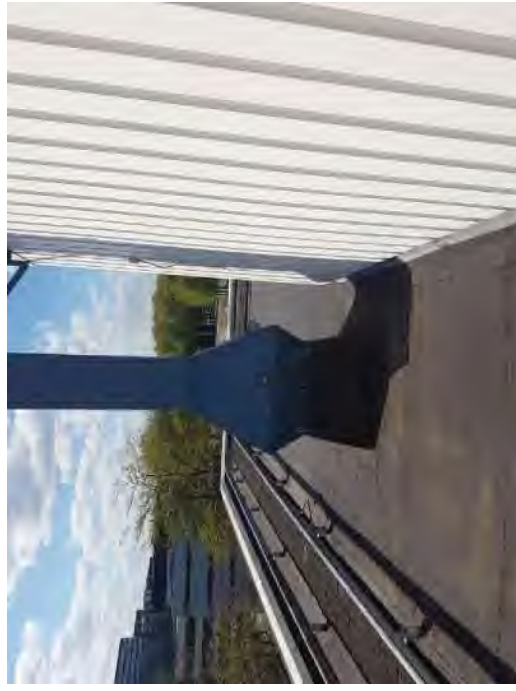
Foto 80: Geb. 1, kit op kabelwartels, afzuiging keuken op dak (M209-V)
