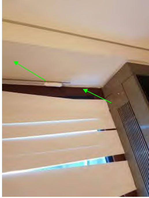
Foto 75: Geb. 1, asbestvrije kit langs gevelkozijn (M204-V, M205-V)
