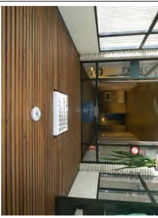
Foto 9: Laagbouw, glaskit kozijnen branddeuren (M008-AA)
