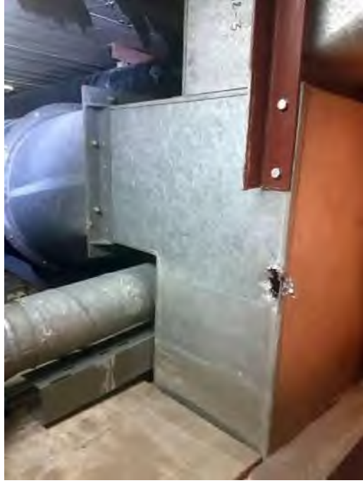
Foto 87: Luchtkanalen, kit in felsnaad (M216-V t/m M219-V, M222-V, M223-V)
