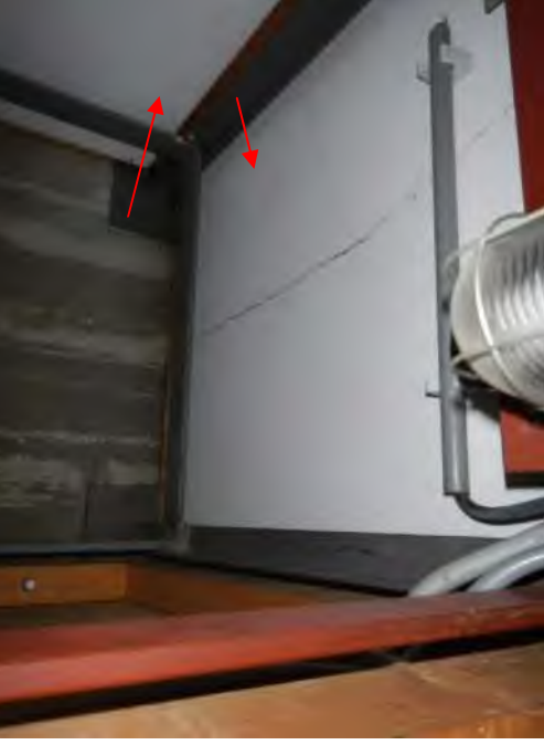
Foto 20: Geb. 1, CV-ruimte losse platen achter kast (M018-ZA, gesaneerd)
