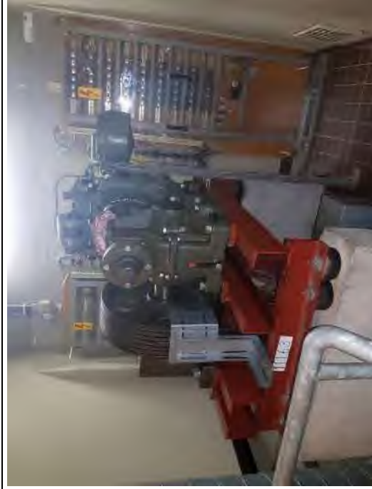
Foto 84: Geb.2, pakking in remschoenen liftmotor (M229-V)
