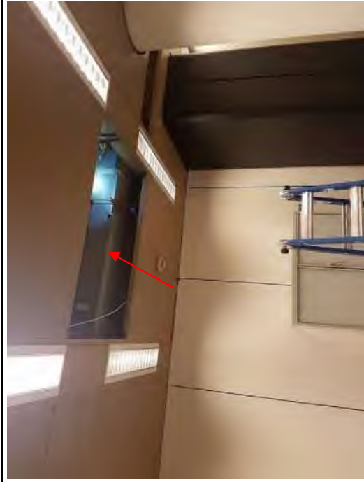
Foto 53: Geb. 1, t/m 4 e verdieping: kit in luchtkanaal (M201-AA)
