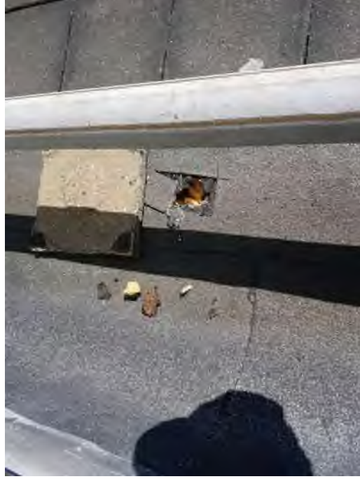
Foto 69: Asbestvrije bitumen dakbedekking diverse daken (M210 t/m M215-V)
