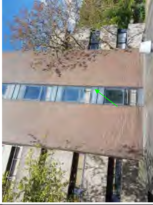
Foto 82: Geb.2, kit langs pui kopgevel (M207-V)
