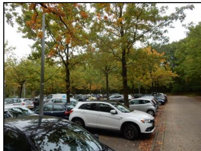
Figuur 4. Parkeerplaats bestaande uit halfverharding.
