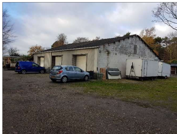
Figuur 5. Loods vanuit oosten
