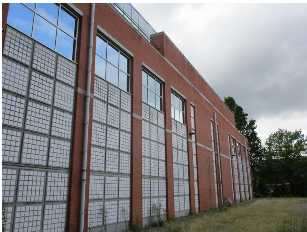
Figuur 1 De planlocatie is gelegen aan de Professor Verbernelaan 35 te Tilburg en bestaat uit een gemetselde, geïsoleerde spouwmuur met een plat dak.
