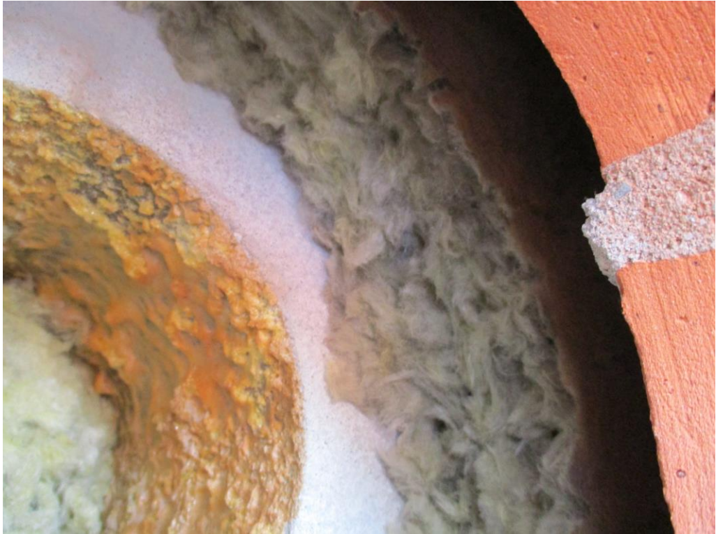
Figuur 3 De spouwmuur is geïsoleerd middels glaswol, waardoor deze ongeschikt is voor vleermuizen.
