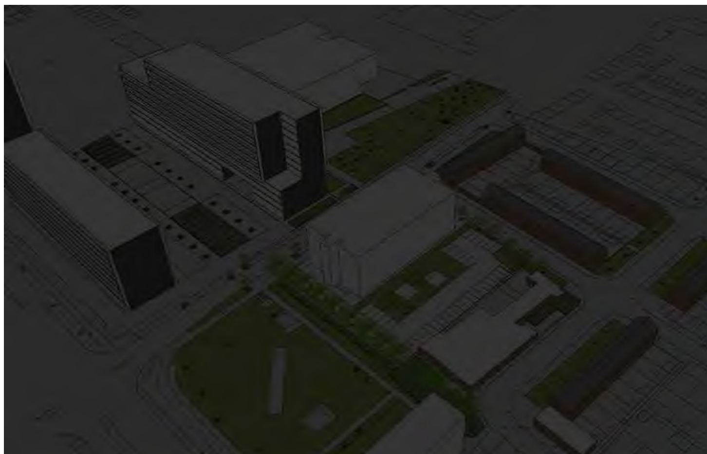
bestaande situatie 19 februari 18:00 uur
