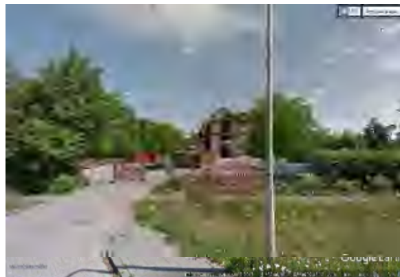
Figuur 12: Sloopwerkzaamheden 2017) (bron Google Earth)
