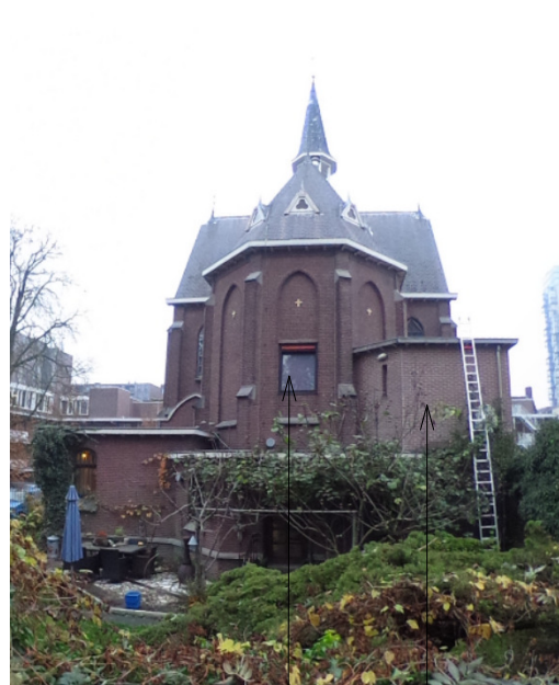
nieuw geplaatst raam
