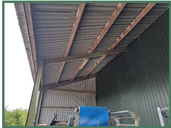
Foto 12: Overkapping achtergevel loads.
