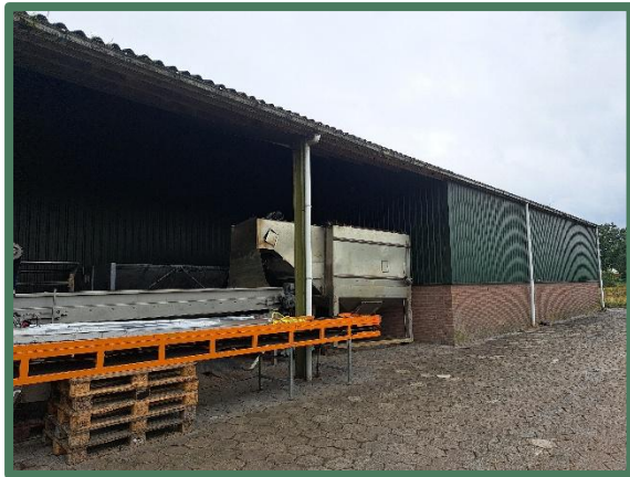
Foto 11: Achtergevel loads (noord).
