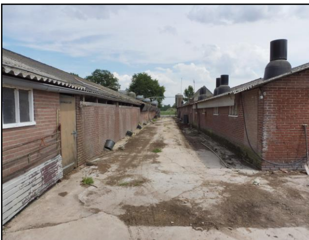
Te slopen varkensstallen.
