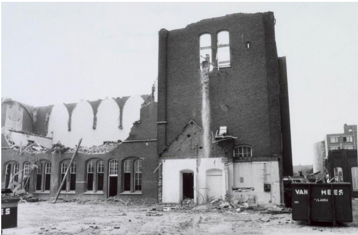
Afbeelding 5.11. De sloop van de kweekschool in 1985, opname vanuit het noordoosten. Op de achtergrond de al gedeeltelijk gesloopte westelijke vleugel, met de binnenmuur en de aanzetten van de gewelven van de kapel (bron: Regionaal Archief Tilburg, fotonummer 018416).
