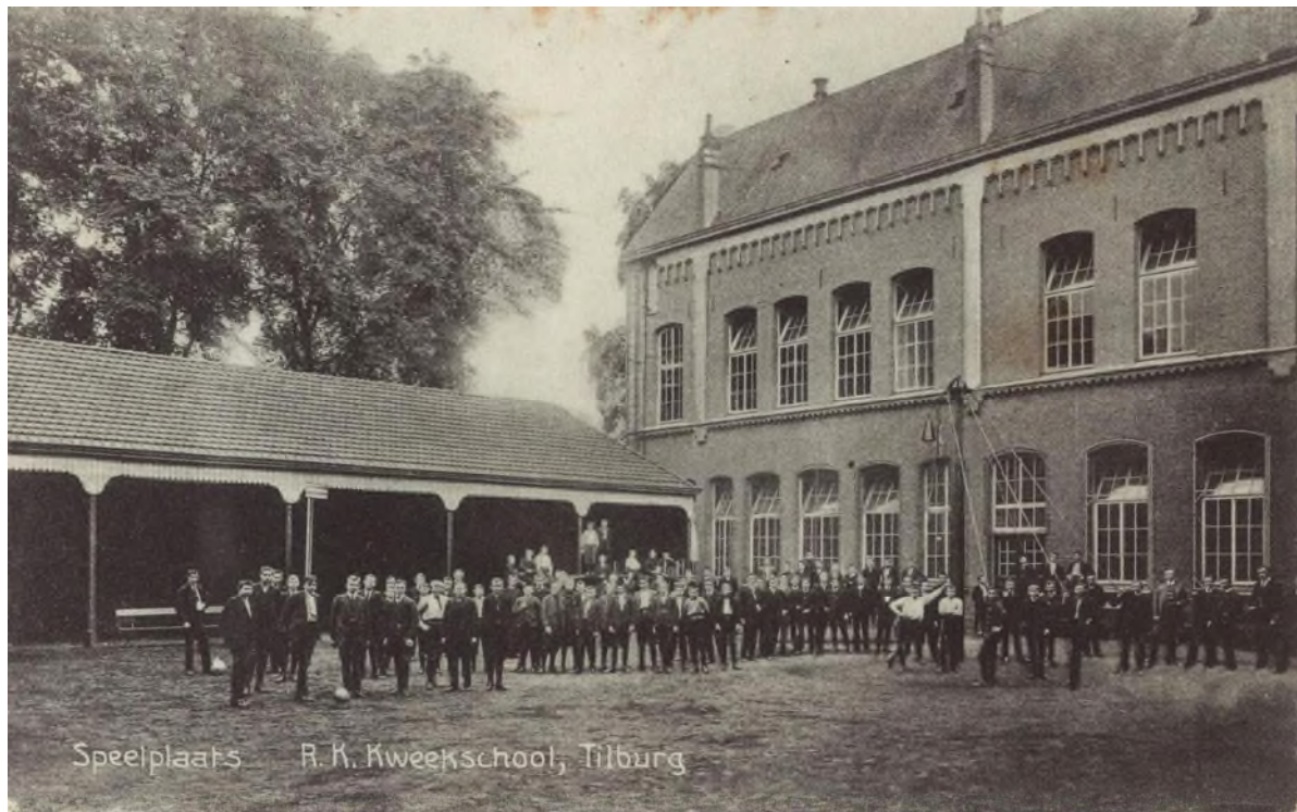
Afbeelding 5.12. De binnenplaats van de kweekschool vanuit het noordwesten, circa 1920. Te zien is dat de laagbouw van de oostelijke vleugel uit een overdekte en aan een zijde open ruimte bestaat, die als overdekte 'speelplaats' fungeerde (bron Regionaal Archief Tilburg, foto 000489)
