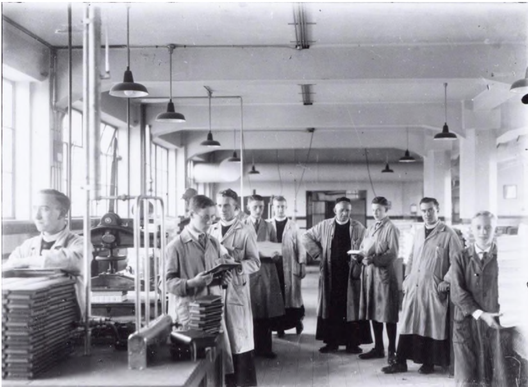
Afbeelding 5.16. Foto uit 1936 van een van de werkruimtes in de nieuwe drukkerij. Duidelijk is het betonnen skelet te zien. De foto is genomen door frater Victorius (Karel) van Gisbergen, die in de jaren dertig het leven en werken in het klooster heeft vastgelegd (bron Regionaal Archief Tilburg, foto 049850).
