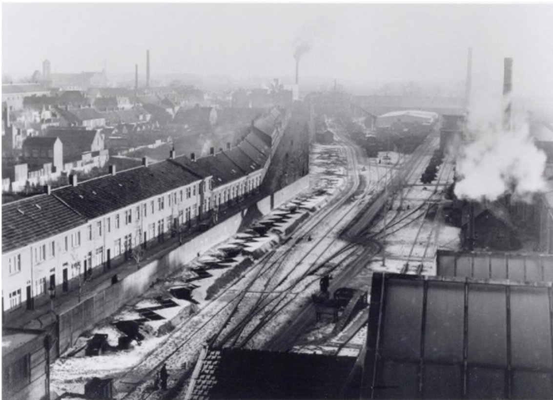
Afbeelding 3.31. De Atelierstraat gezien vanaf het dak van de locstelplaats [60]. De opname zou uit 1939 dateren, en is vermoedelijk in december van dat jaar genomen. Linksonder is het oude trafogebouw zichtbaar, dat in het verlengde van de rolbaan in de oudste locstelplaats [70] lag, iets westelijk van de kruising van de Atelierstraat met de Locomotiefstraat. Zichtbaar is dan ook het grootste deel van de bebouwing aan de Atelierstraat, met de diepe tuinen aan de achterzijde en de daarachterliggende bebouwing van de Lange Nieuwstraat. Let ook op de schuilplaatsen voor luchtaanvallen, die in een zigzag-patroon parallel aan de noordmuur van het werkplaatsterrein zijn aangelegd (bron: Regionaal Archief Tilburg, foto 037033).
