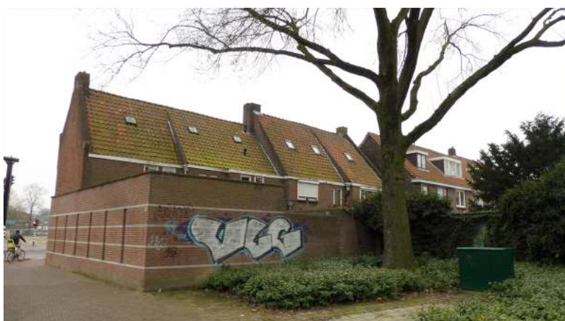
Plangebied achtertuinzijde, kijkrichting west
