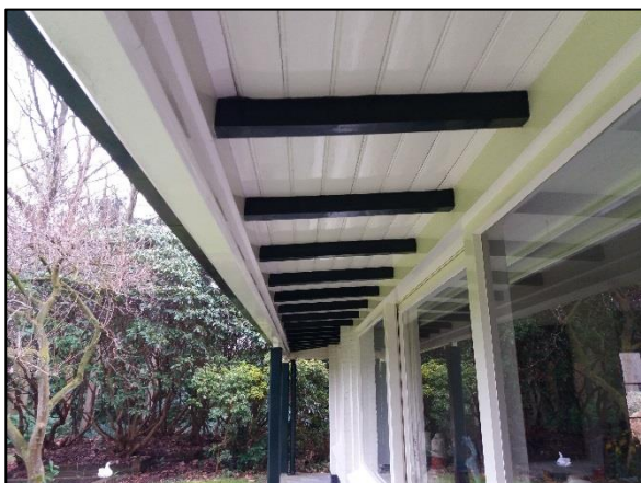
Afbeelding 3.3 Onderzijde bekistingen goot
