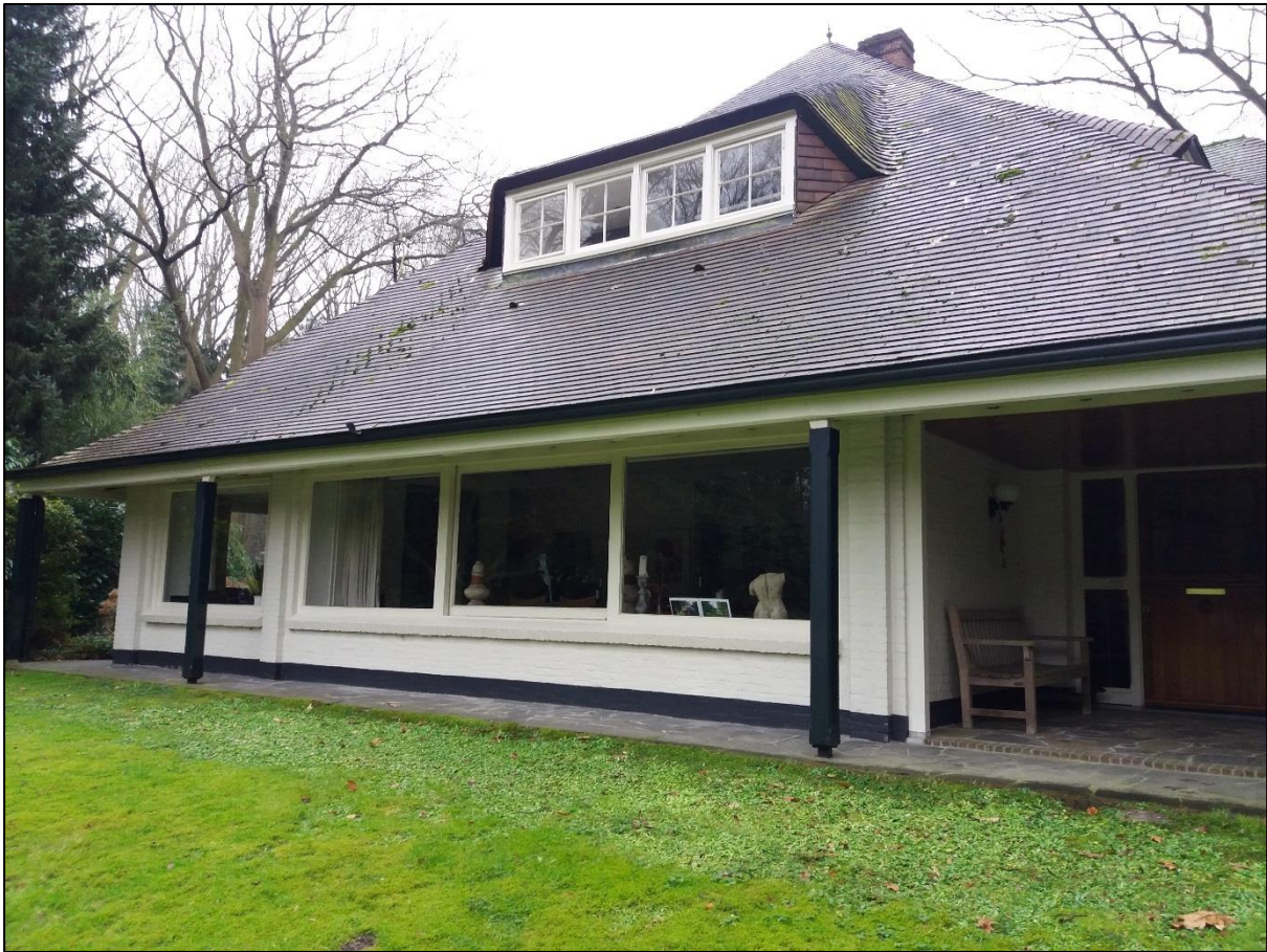
Afbeelding 2.1 voorzijde woning met tentdak van leisteen
