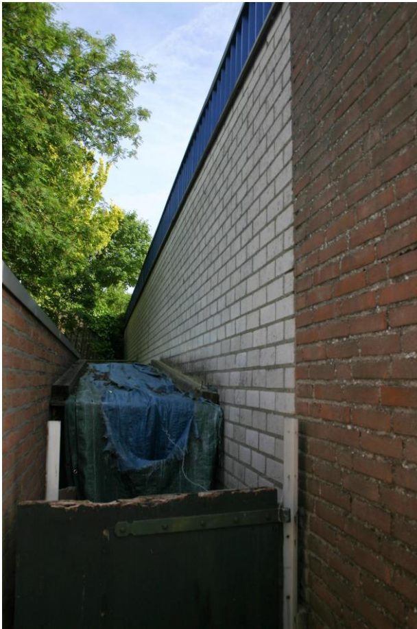
Figuur 4.1.3. De westelijke zijgevel
