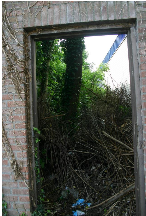
Figuur 4.1.4. De smalle ruimte tussen de loodsen.
