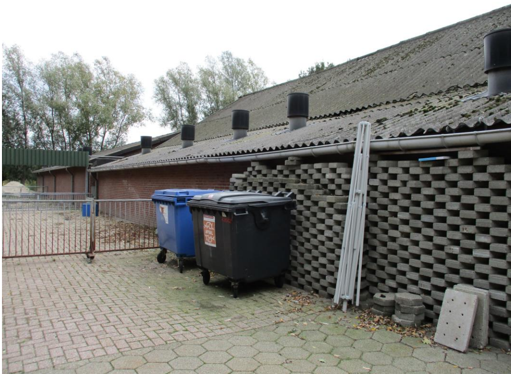
Figuur 6 De overige bebouwing aan de Heikantsebaan 4 bestaat ook uit veestallen. Deze zijn opgetrokken uit gemetselse steense muren en geïsoleerde golfplaten daken.
