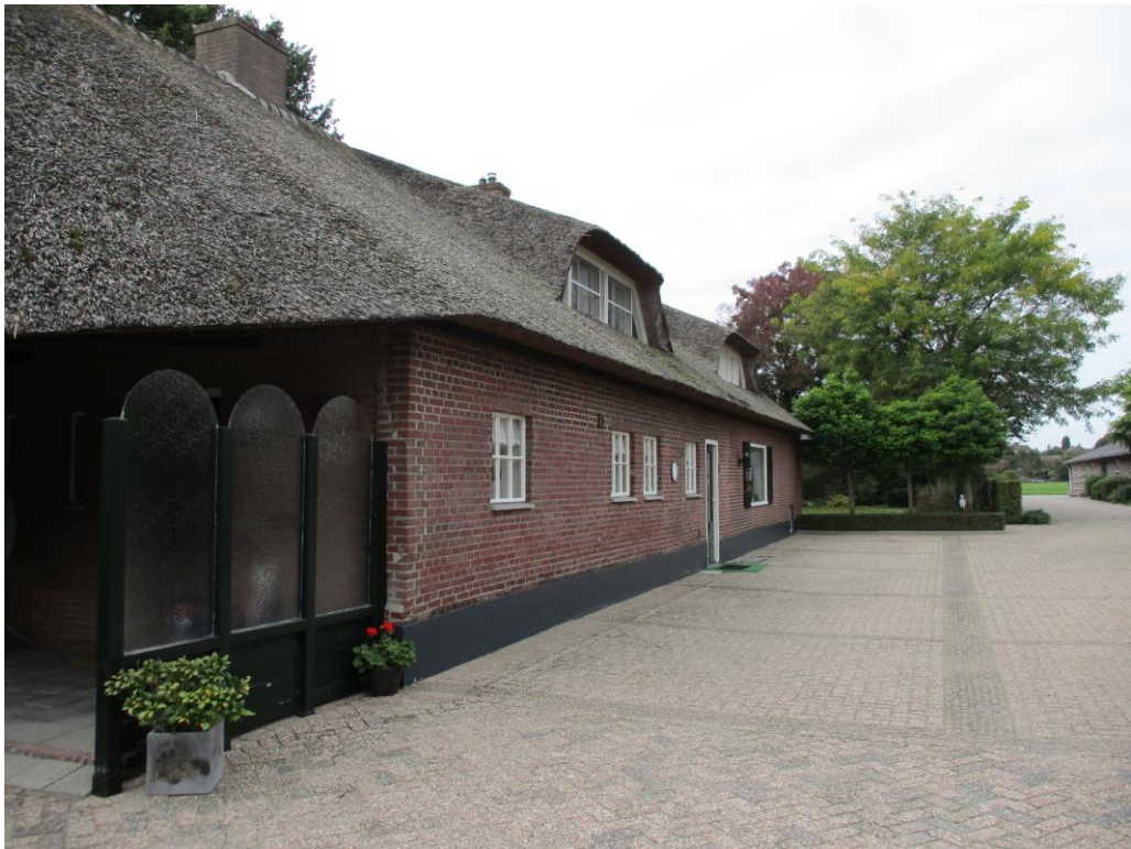
Figuur 3 De bedrijfswooning aan de Heikantsebaan 5-7. De woning is opgetrokken uit gemetselde steense muren en een rieten dak.
