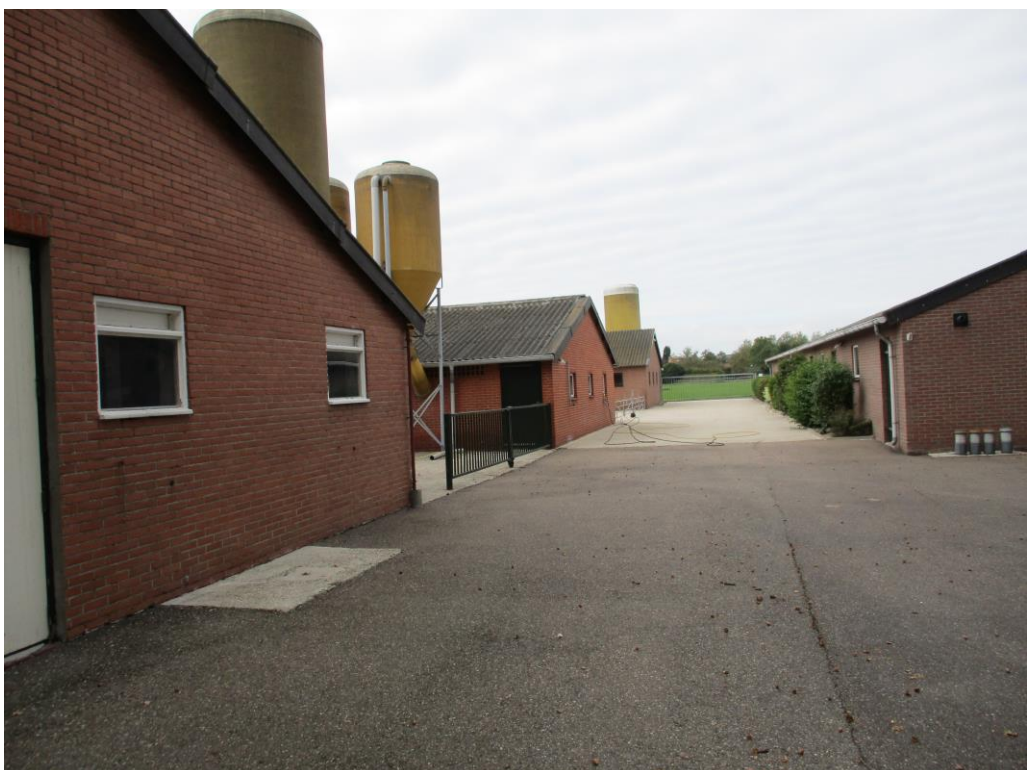
Figuur 4 De overige bebouwing aan de Heikantsebaan 5-7 bestaat uit veestallen. Deze zijn opgetrokken uit gemetselde steense muren en geïsoleerde golfplaten daken.
