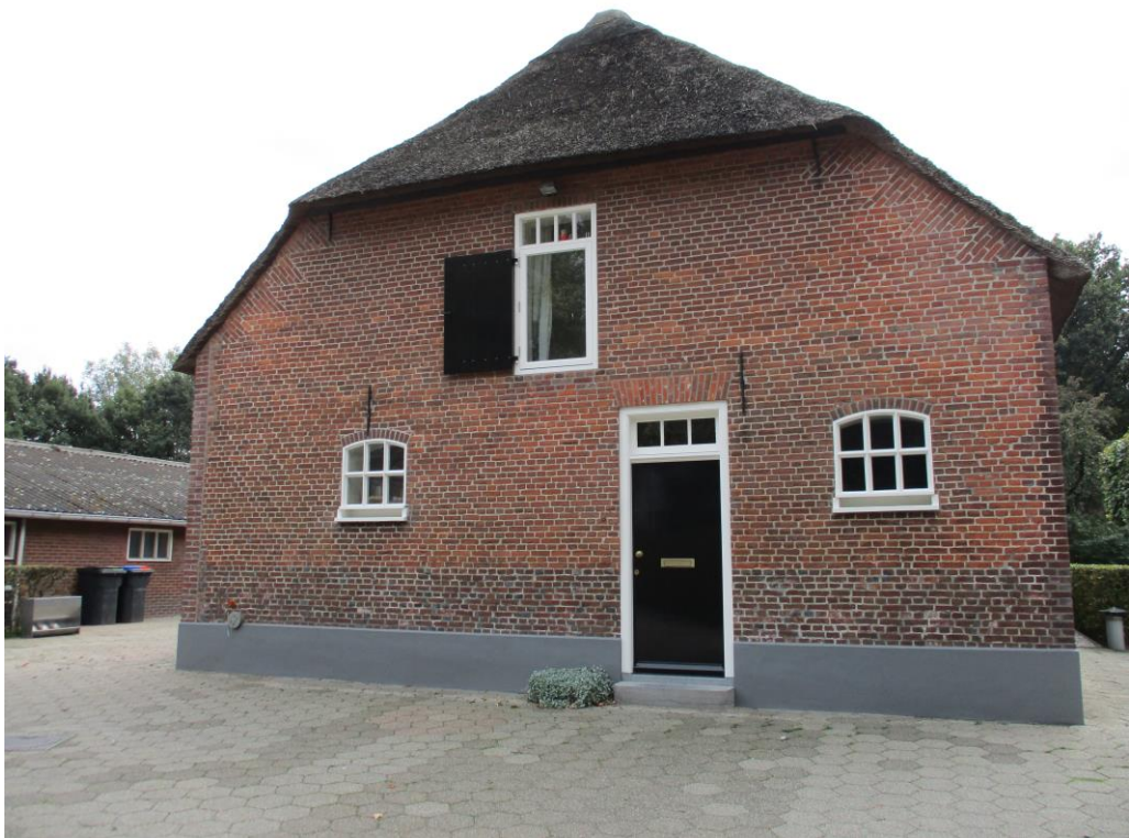
Figuur 5 De bedrijfswoningwoning aan de Heikantsebaan 4. Ook deze woning is opgetrokken uit gemetselde steense muren en een rieten dak.
