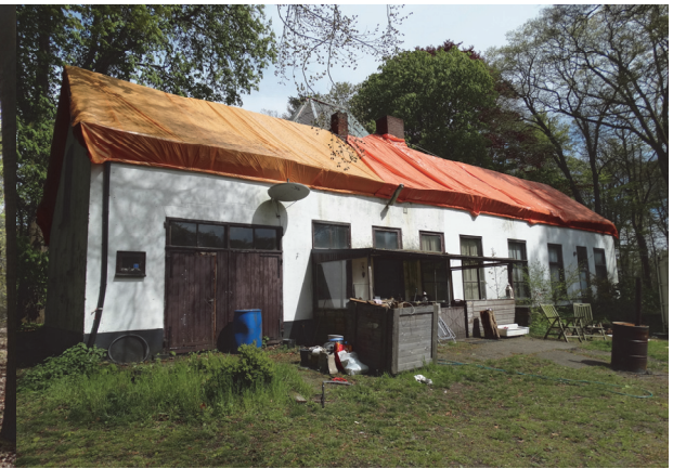
Figuur 4: Impressie voorzijde van de woning. Het dak is bedekt met kunststofzeil. Er is een overkapping aanwezig
