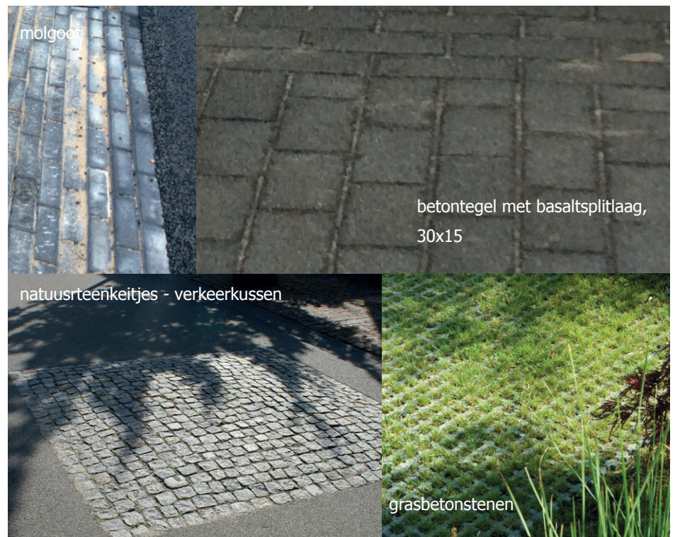
materialen Boslaan - asfalt, kinderkopjes, keien, grasstenen, gebakken klinkers
