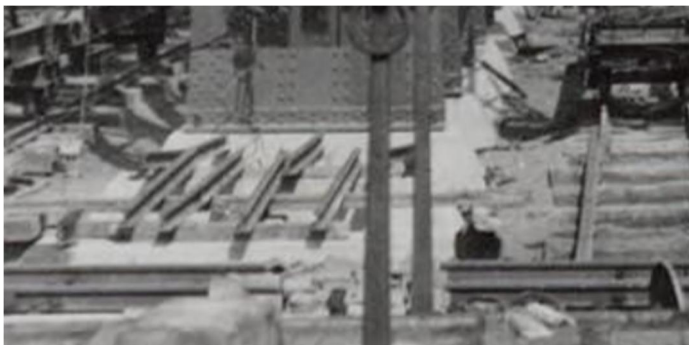
Figuur 3.7. Overzicht en detail (rechts) van de bouw van de loods in 1931-33. Het detail laat de zware funderingen van de middenstaanders zien (RAT beeldarchief foto 036951)
