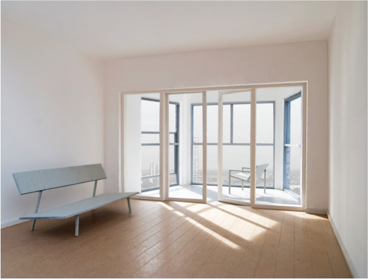
Winterloggia; een buitenkamer die bescherming biedt tegen geluid, wind en regen
