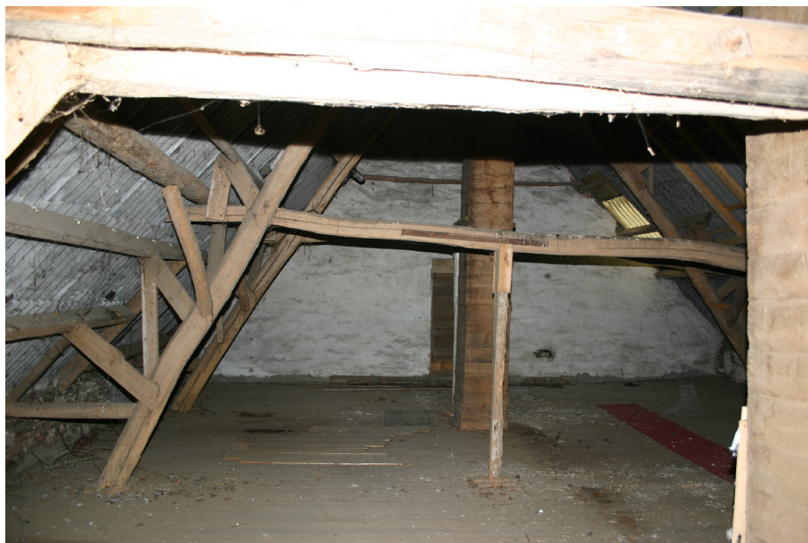
Afb. 22 De gekunsteld ogende dakconstructie van het stalgedeelte van de boerderij, met lokaal hout vervaardigd.
