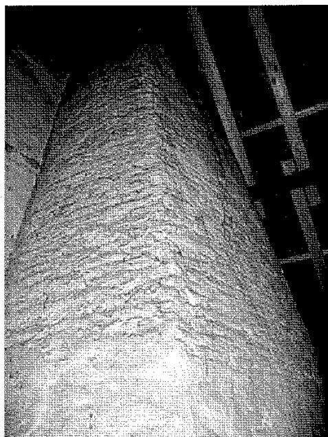
Rookkanaal tegen brandmuur.
