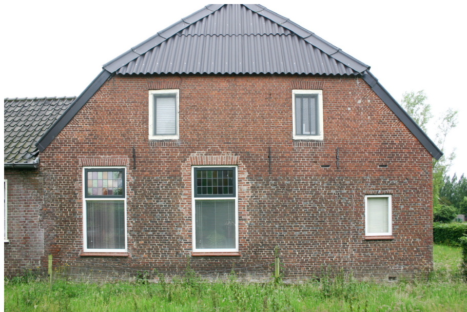
Afb. 15 De kopgevel van de boerderij heeft alleen op zolderniveau oorspronkelijke gevelopeningen. Links de aansluiting van het later gebouwde bakhuis.
