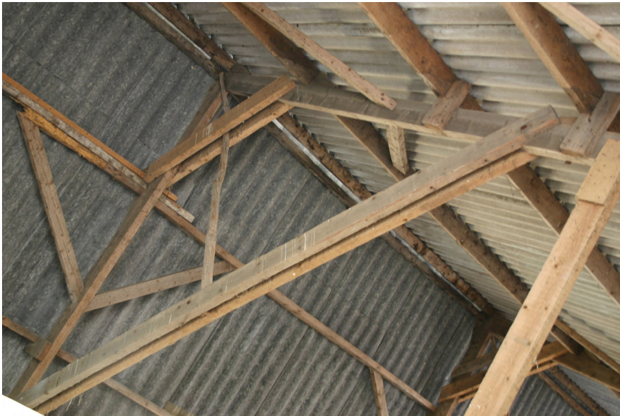
Afb. 26 Kapconstructie in de schuur.
