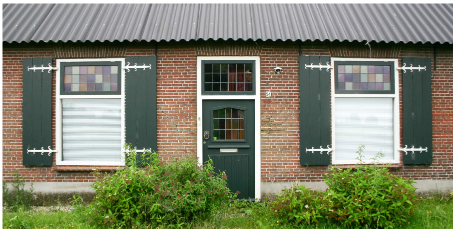
Afb. 8 De voorgevel van het woongedeelte met oorspronkelijke, symmetrische opzet. De vensters en deur zijn niet oorspronkelijk. Ze dateren uit het eerste kwart van de twintigste eeuw.
