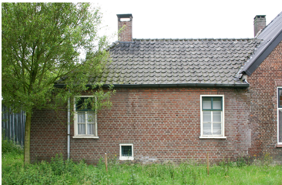
Afb. 30 De gevel van het bakhuisje verkeert nog vrijwel in de oorspronkelijke toestand. Het dak is gedekt met pannen.
