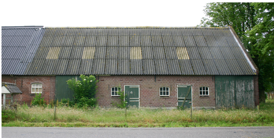
Afb. 24 De gevel van de voormalige schuur, gebouwd in 1928. Staldeuren en stalramen zijn toegevoegd.
