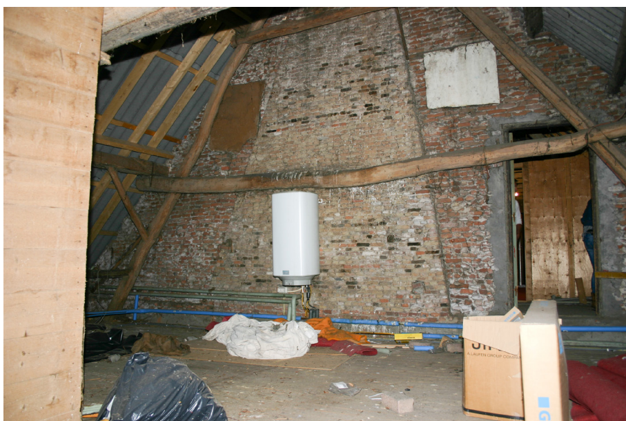
Afb. 21 De brandmuur op het niveau van de zolder. Mogelijk is hier baksteen gebruikt afkomstig van de voorganger van de huidige boerderij.
