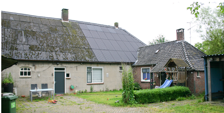
Afb. 13 De achtergevel is gecementeerd, een situatie die zeer waarschijnlijk niet oorspronkelijk is. In de gevel zijn geen oorspronkelijke invullingen meer aan te treffen. De gevel heeft ankers die samen het jaartal 1871 vormen.
