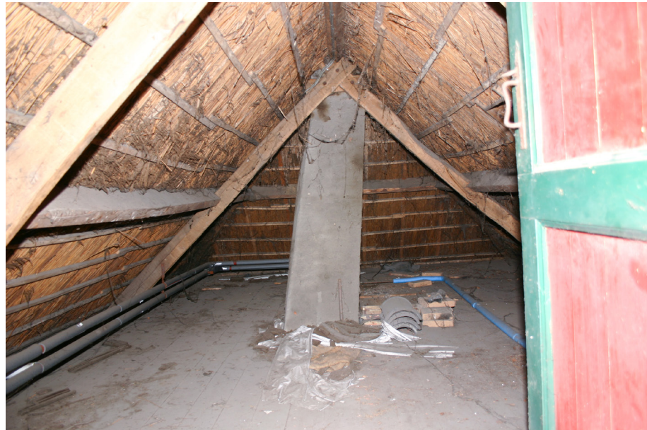
Afb. 31 De kapconstructie van het bakhuisje. Onder het huidige pannendak gaat nog een oudere dakbedekking met riet schuil.
