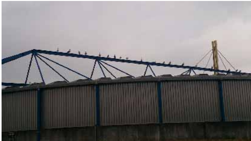
Rustplaats meeuwen op warmwaterleidingen waterzuivering.
