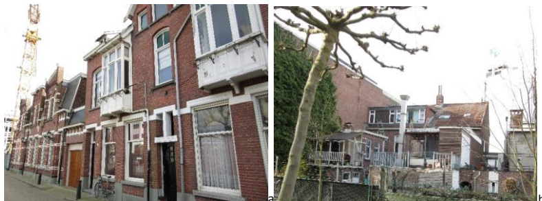
Afbeelding 5.1 a) De woningen in het plangebied. b) achterzijde van de woningen.
