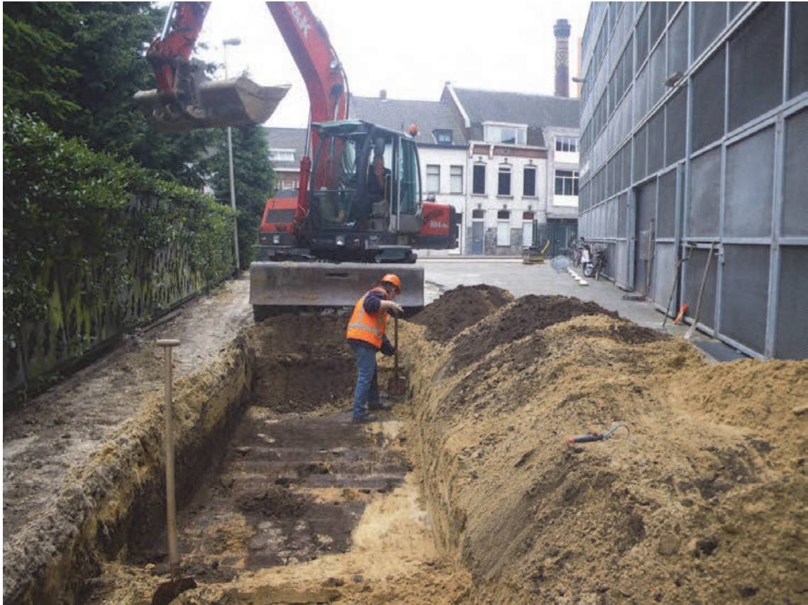
Fig. 4.1: Het uitgraven van de sleuf.
