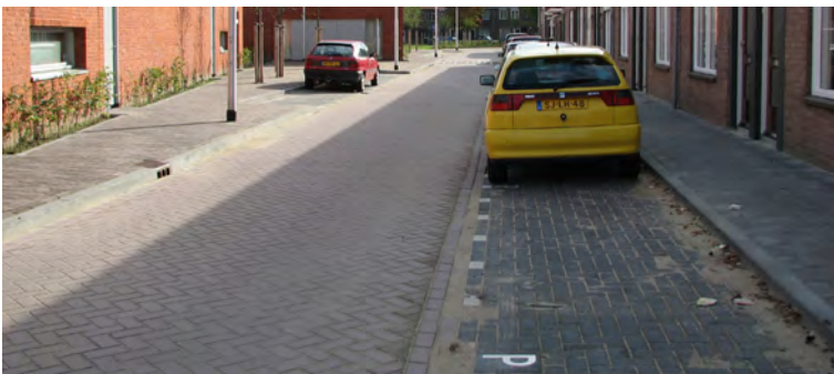
3. aansluiting nieuwbouwproject op bestaande profielen
