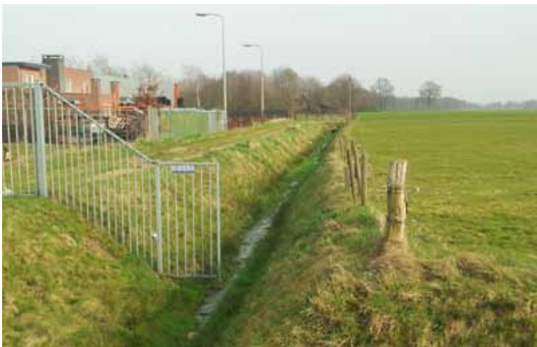
Achterzijde van bedrijven aan de Energieweg. De oostelijke begrenzing wordt gevormd door een watergang welke is voorzien van een schouwpad.
