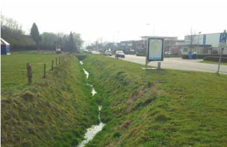
Het plangebied wordt aan de westzijde begrensd door de Handelsweg. Deze weg is onderdeel van bedrijventerrein Kreitenmolen.
