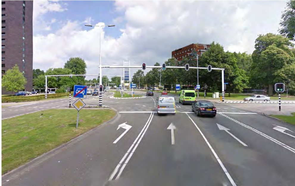
Afbeelding: zicht vanaf Kempenbaan met rechts het hotel, links de Cenakeltorens
