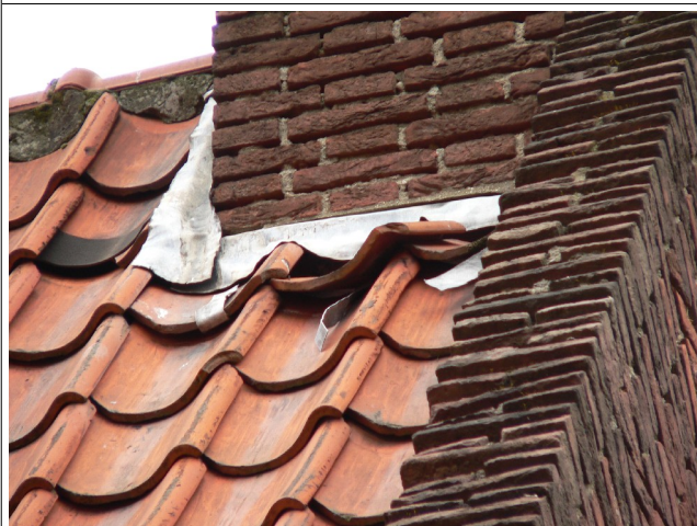
Potentiële nestplaatsen van huismus en gierzwaluw.
