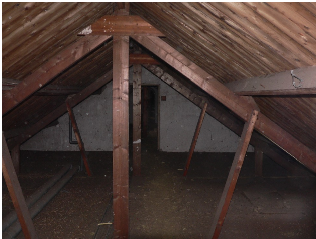
Zolderruimte van de woningen aan de Ringbaan Zuid
