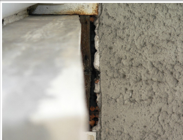
Toegang tot ruimte achter plafondplaten op balkons.
