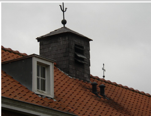
Klokkenstoel geeft vleermuizen en vogels toegang tot zolderruimten.
