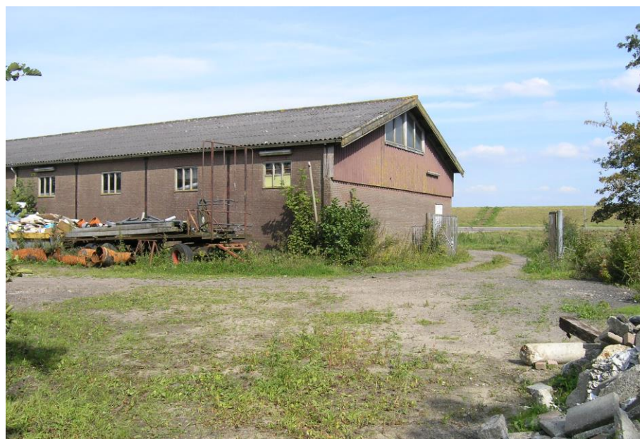
Plangebied met de loods gezien richting de Zeedijk (4 september 2017)
