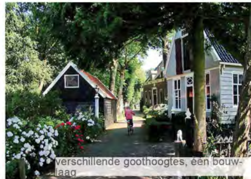
bedrijfsgebouwen aan de Hellingweg
