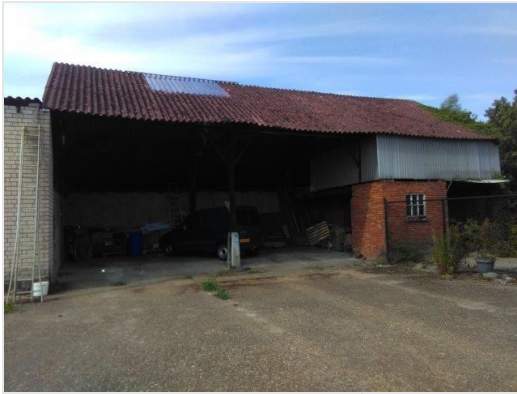
Voorste loods achter woning nr. 1, afdak
