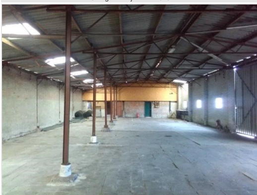
Achterste loods achter woning nr. 1, overzicht
