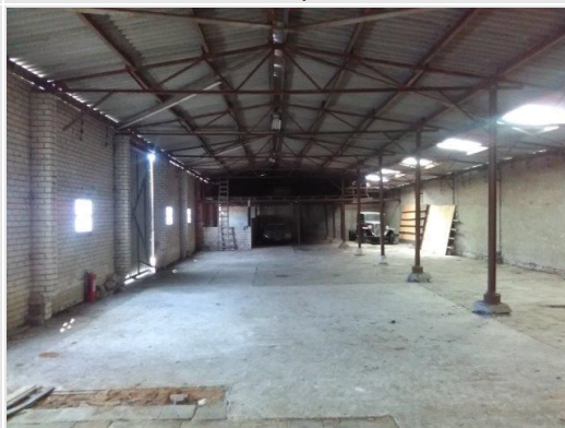
Achterste loods achter woning nr. 1, overzicht
