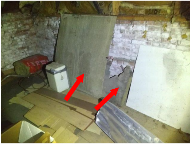
Losse plaat bij trap
