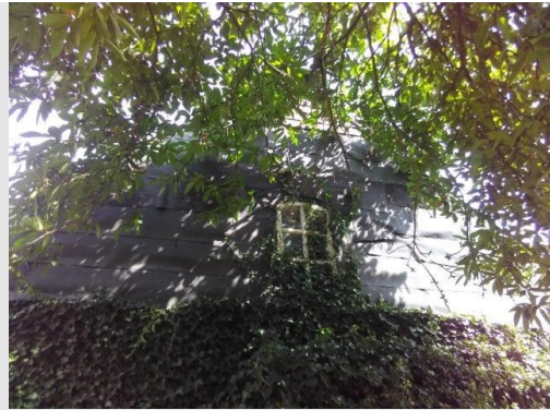
Zijgevel van aangebouwde schuur
