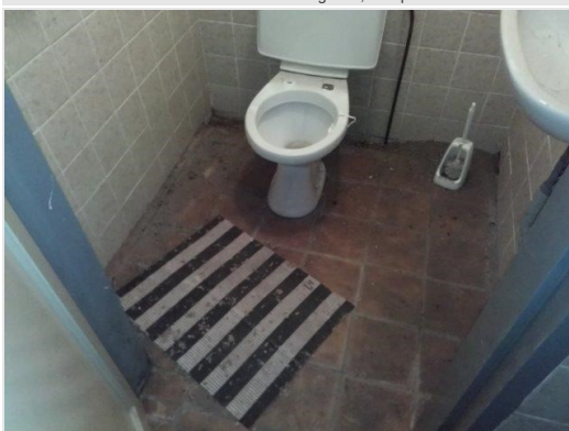
Voorste loods achter woning nr. 1, toilet
