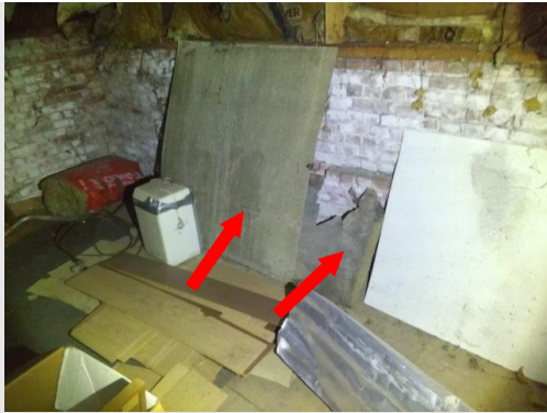
Losse plaat bij trap
