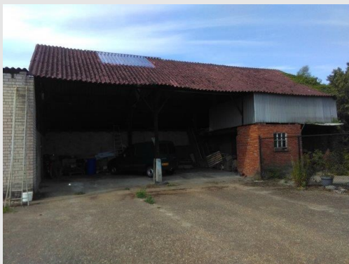
Voorste loods achter nr. 1, dak
