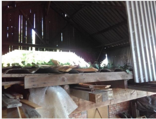
Voorste loods achter woning nr. 1, afdak, damwandprofiel zolder en wand
