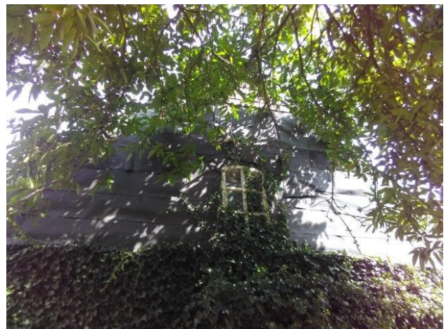
Zijgevel van aangebouwde schuur
