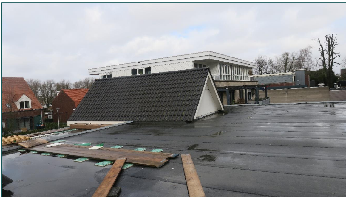
Figuur 3 Eén van de twee zadeldaken aan de achterzijde van het gebouw (ook zichtbaar in figuur 1).
