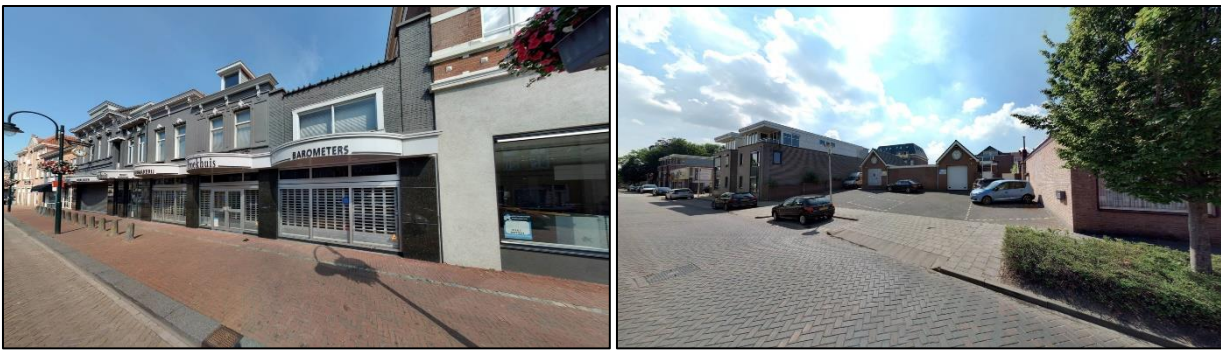
Aanzichten huidige situatie besluitgebied vanaf de Grote Kerkstraat en de Oostdam. Bron: Cyclomedia Technology, 2022.
