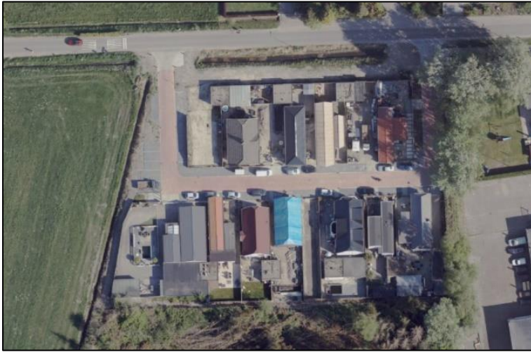
Uitsnede luchtfoto ter plaatse van woonwagenlocatie Westlandse Langeweg. Bron: Cyclomedia Technology, 2023.
