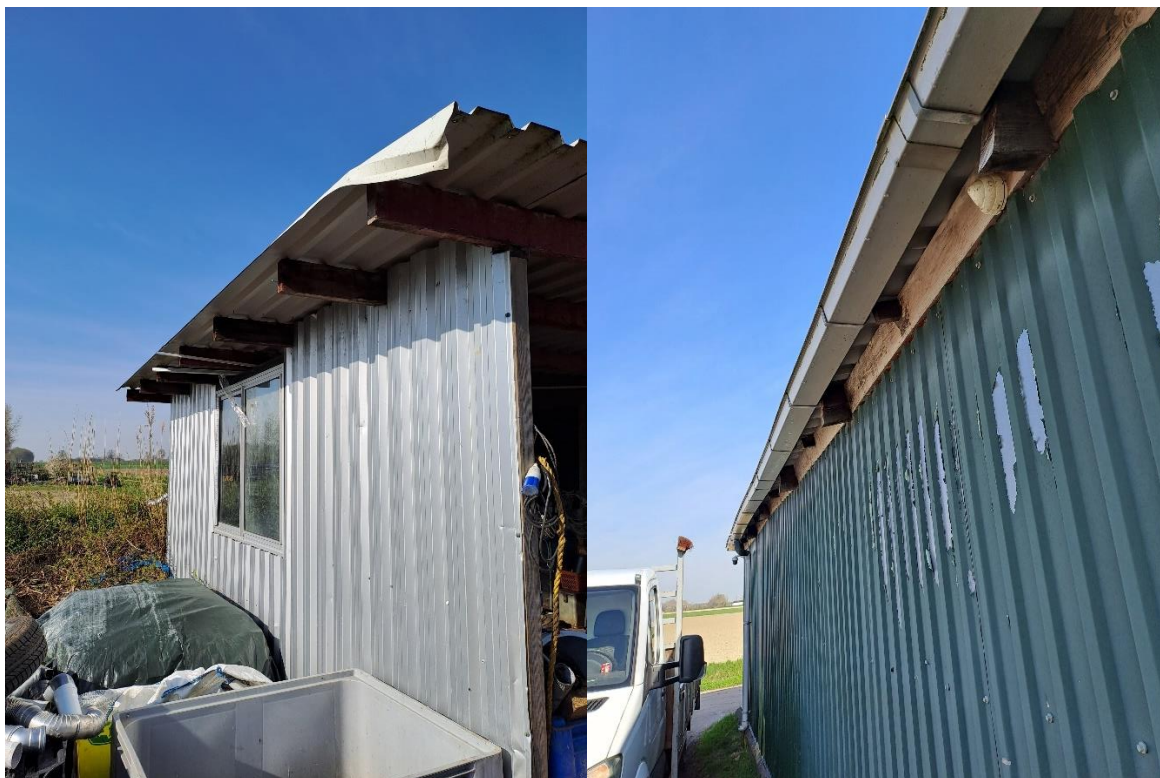
Zijaanzicht te slopen schuurt (links) en onderaanzicht van de dakrand van bestaande bebouwing (rechts)
