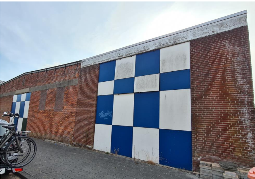
Figuur 5: Achterkant te slopen bebouwing gezien vanaf de Westgroeneweg
