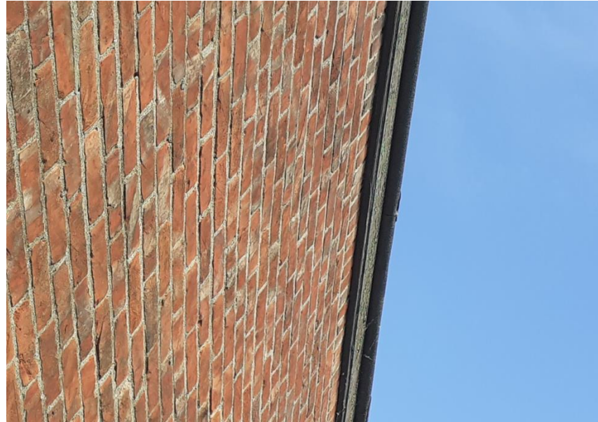
Figuur 12: Houten dakrand langs de gevel aan de Westerstraat
