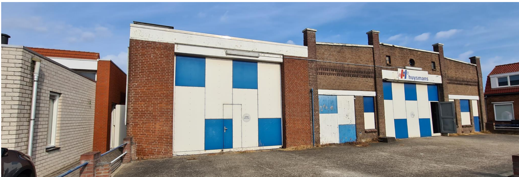
Figuur 4: Voorkant te slopen bebouwing gezien vanaf de Westersstraat
