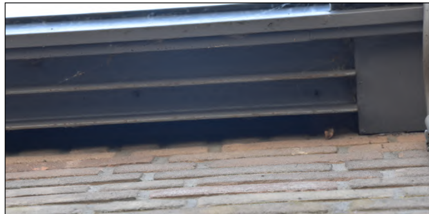
Figuur: dergelijke openingen en kieren achter plaatmateriaal kunnen toegang bieden tot ruimtes onder het dak of tot de spouw. Hier kunnen gierzwaluwen nestelen of vleermuizen verblijfplaatsen hebben.
