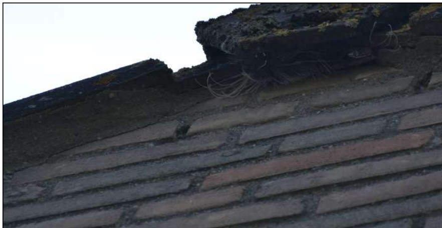
Figuur: dergelijke kieren bij nokpannen kunnen toegang bieden tot ruimtes onder het dak. Hier kunnen gierzwaluwen nestelen.
