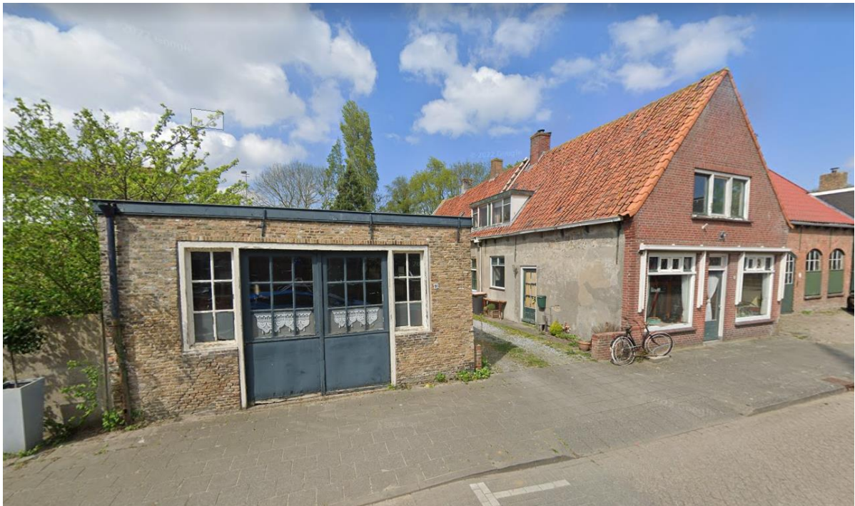
Afbeelding 9: straatbeeld vanaf de Dorpsweg. Het linker gebouw, Dorpsweg 91, zal gesloopt worden.
