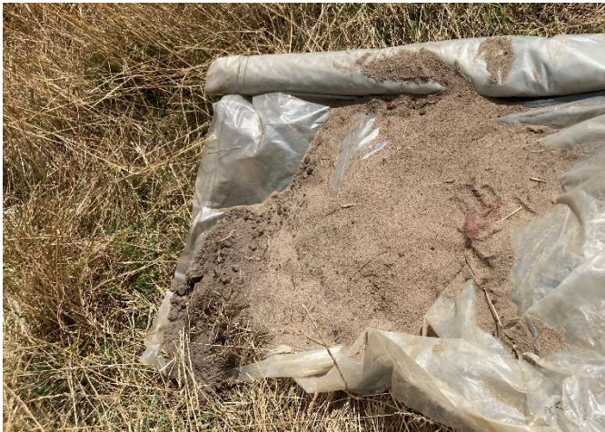
Figuur 4.1: Aangebracht (drainage)zand
