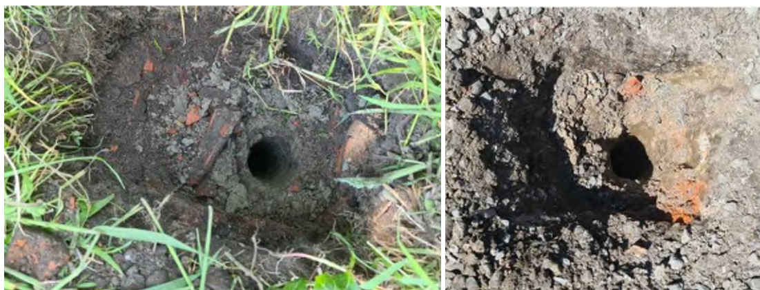
Afbeelding 5.1. Inspectiekuilen bij meetpunt 108 (links) en 109 (rechts)
